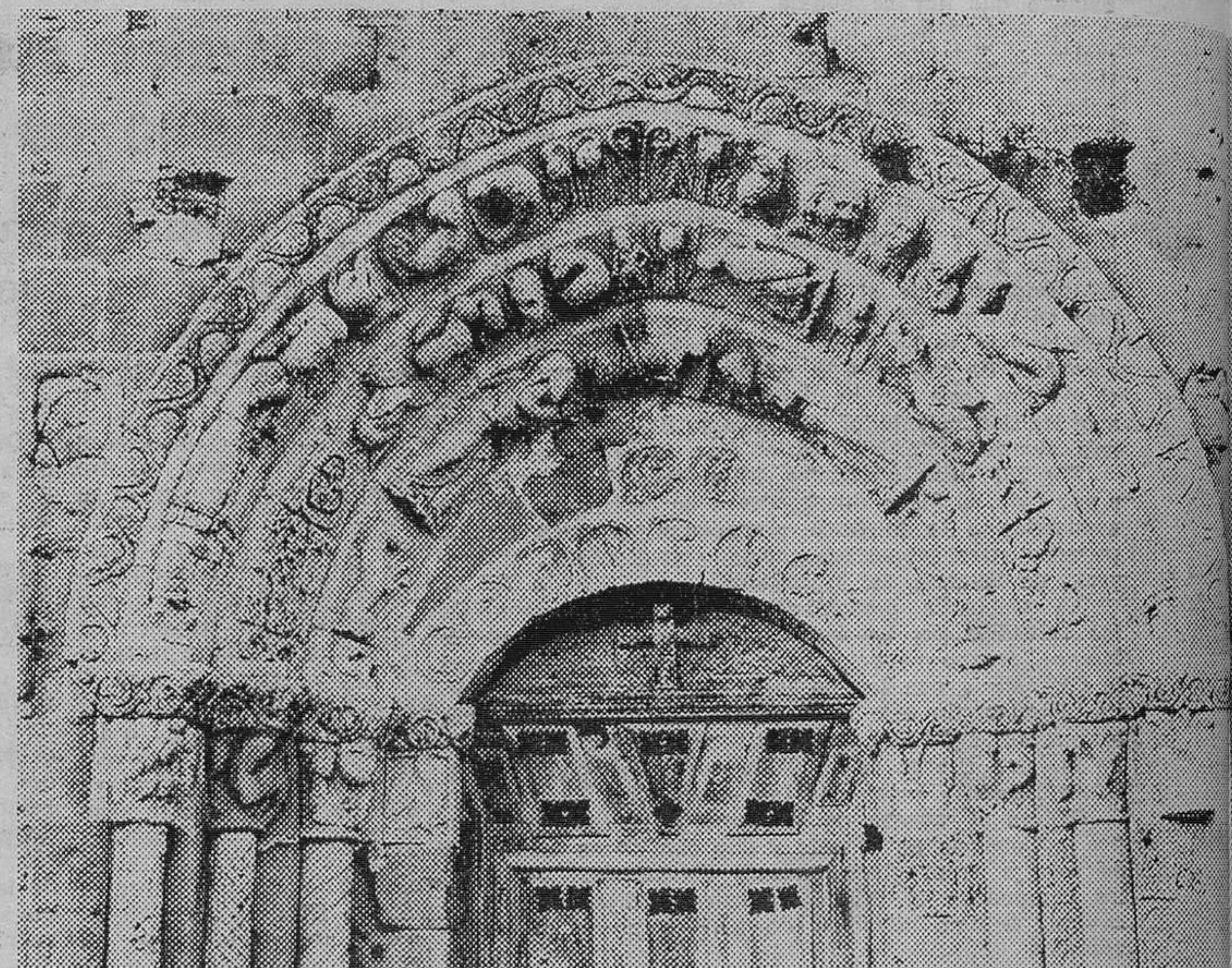
Obras de arte como este pórtico de la Iglesia de Soto de Bureba, han de conservarse, aunque se están perdiendo y con faltas. — (Foto FEDE).
