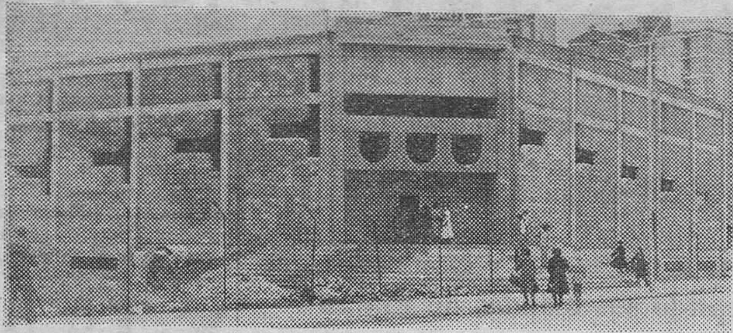
Aspecto exterior que presenta el nuevo templo parroquial de La Sagrada Familia, en avanzada fase de construcción y cuyas obras inspeccionó el Arzobispo después del acto religioso. (Foto FEDE).
