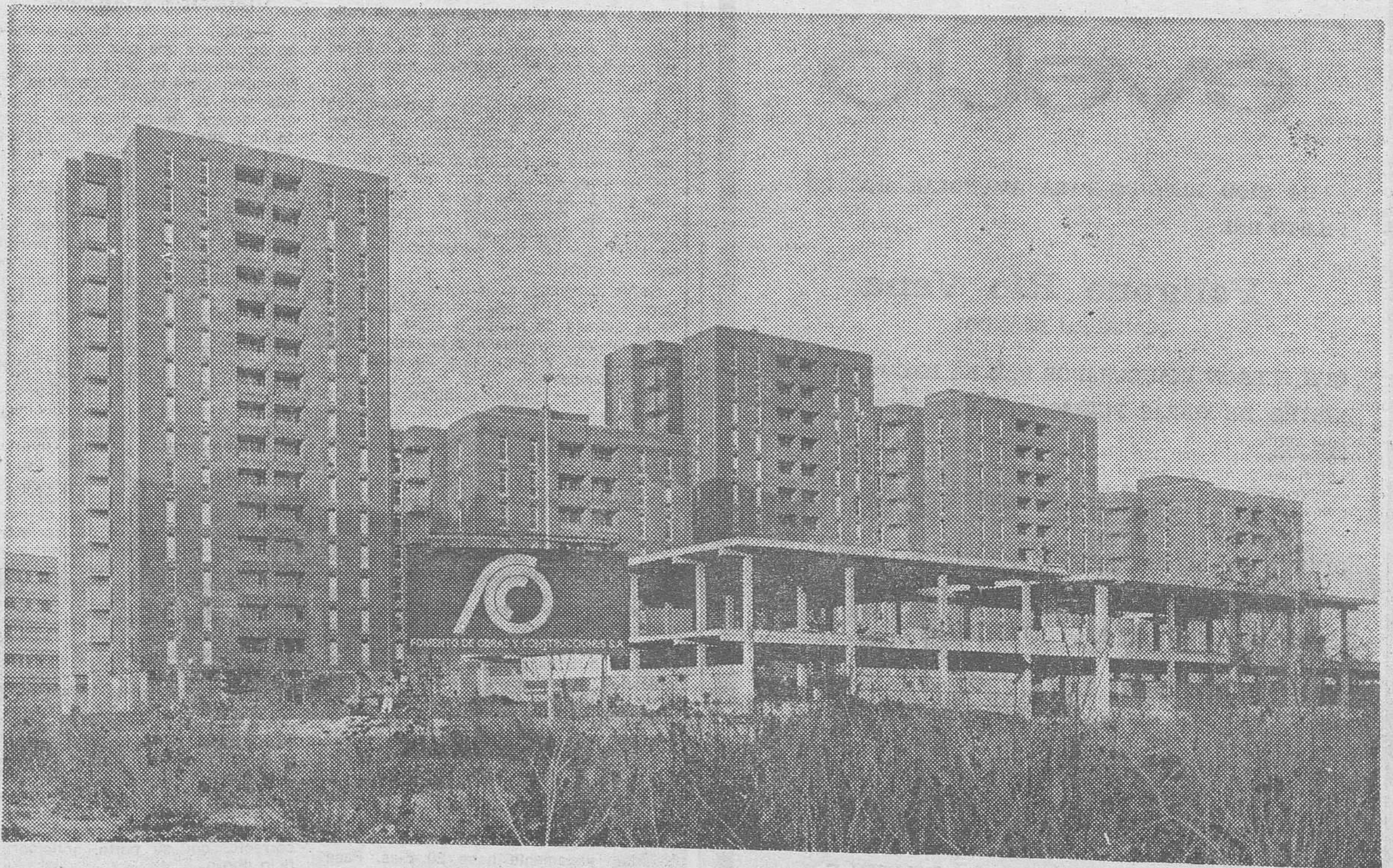
Vista parcial de las 691 viviendas que hemos construido en el Polígono Carrero Blanco de esta ciudad para el I. N. V.
