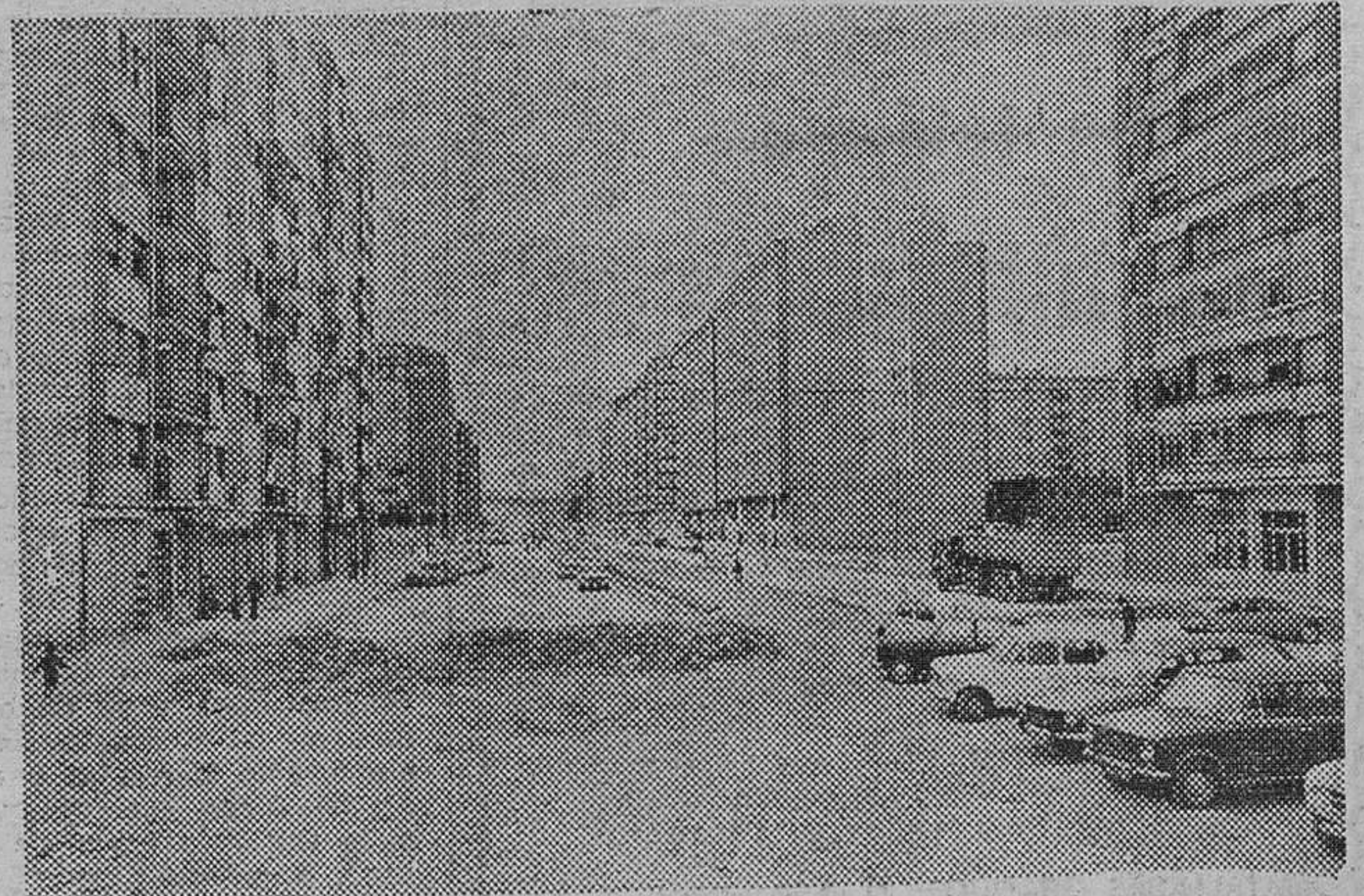
La calle de Eladio Perlado, a punto de estrenar su nueva pavimentación
