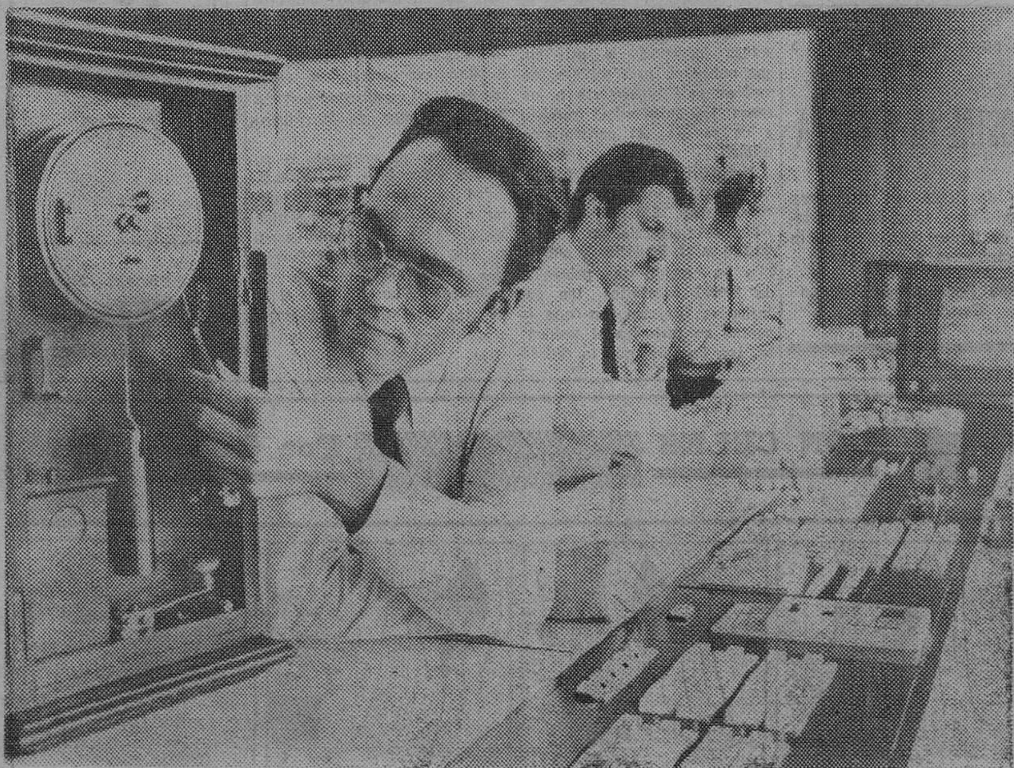
Aquí vemos el primer avisador de incendios del Mundo (izquierda), que Verner von Siemens construyó en 1851 para el parque de bomberos de Berlín. A su alrededor, una central de control de incendios de hoy, la instalada, también por Siemens, en el parque de bomberos de Augsburgo (Alemania). Mucho ha cambiado. Hoy es una computadora la que recibe las llamadas, las elabora y ofrece, en cuestión de segundos, el más eficaz plan de acción. — (Foto FIEL).
