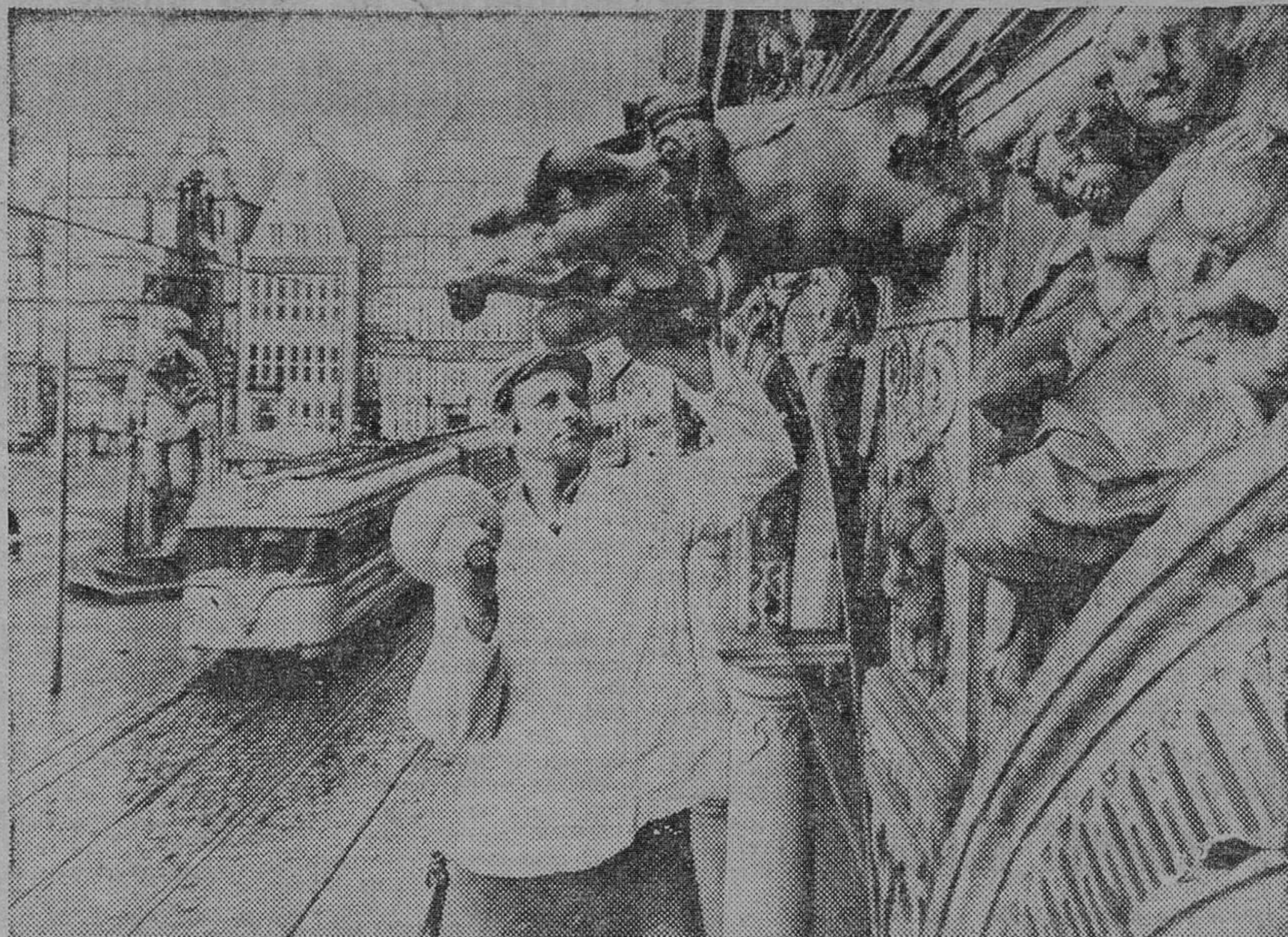
Bremen. — Al objeto de prevenir a los deterioros irreparables de las heladas invernales, de la contaminación ambiental y sobre todo de la humedad, todos los años se revisa y repara cuidadosamente la fachada renacentista del histórico Ayuntamiento de Bremen (República Federal de Alemania), cuyos relieves, de piedra arenisca, fueron esculpidos hace más de 350 años. El picapedrero de la foto rellena todas las fisuras, con lo que se evita la penetración de la humedad y que el agua, al helarse, cause daños materiales
