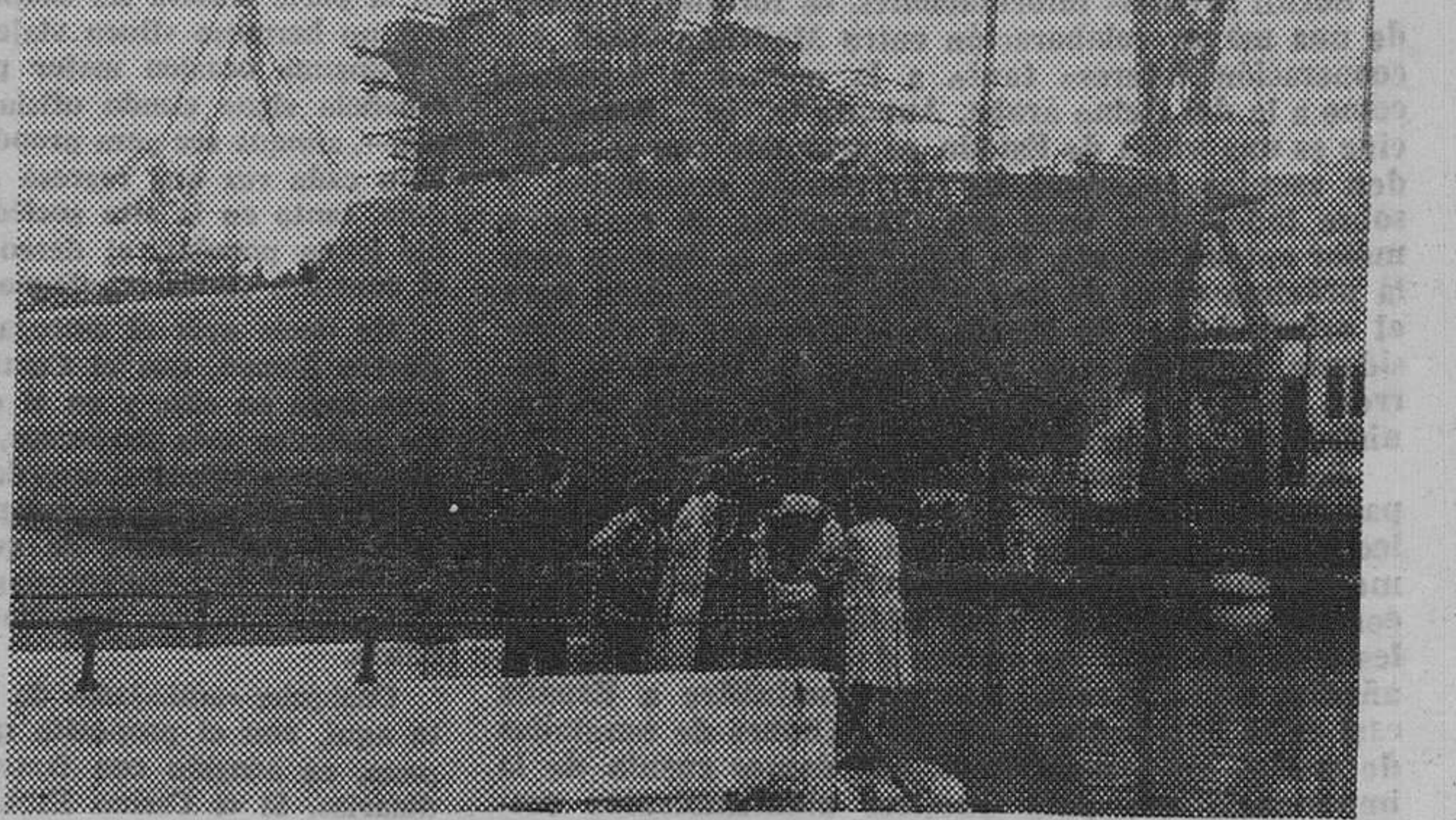
En un astillero, la construcción de un buque.
