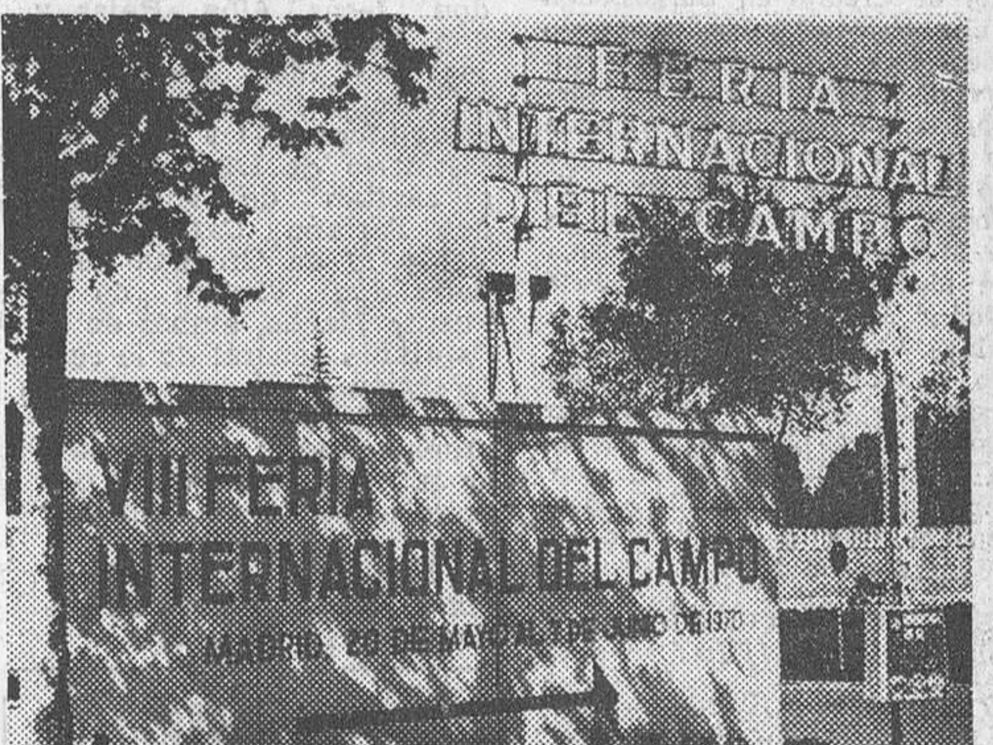
Madrid. — En el recinto de la Feria Internacional del Campo que se inaugurará próximamente, se están llevando a cabo los trabajos para la total preparación del recinto para la inauguración. La fotografía muestra los «stand» casi ya preparados para recibir a los visitantes. — (Foto CIFRA)
