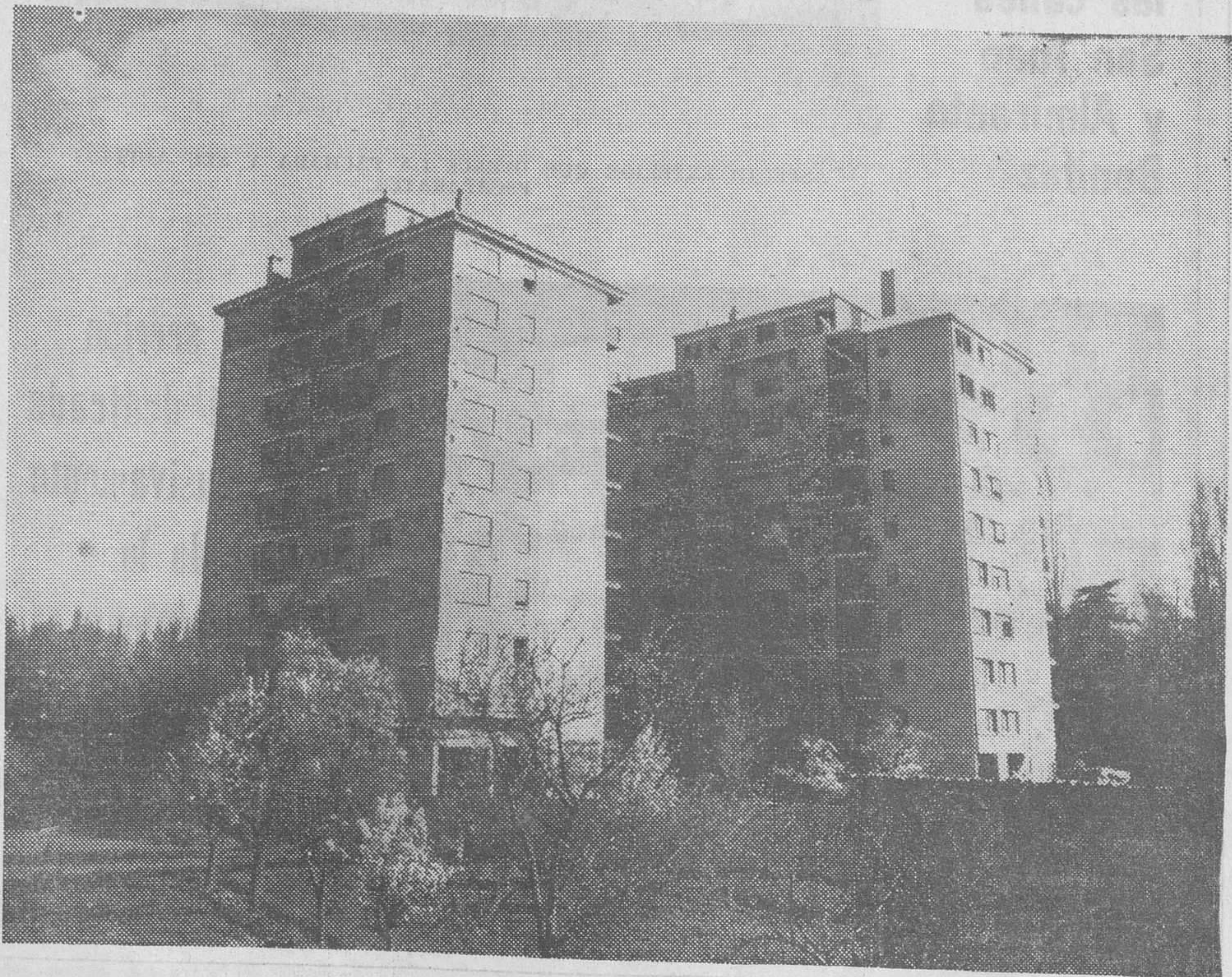
Una perspectiva, tomada desde la parte posterior, de los dos bloques construídos por la empresa «Firestone».—(F. "Fede")
