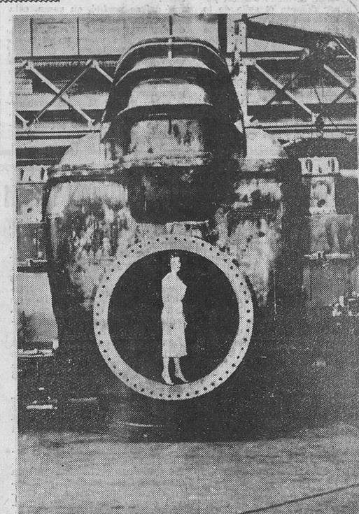
La mayor bomba de cuantas se han fabricado hasta la fecha en el Mundo, con un peso de 80 toneladas, acaba de ser terminada en la factoria Werthington de Harrison (Nueva Jersey). La bomba, con destino a los servicios de alcantarillado de Rio de Janeiro, tiene una capacidad de un millón de litros por minuto. De las dimensiones de su embocadura da idea la silueta de la muchacha situada de pie en la misma entrada.
