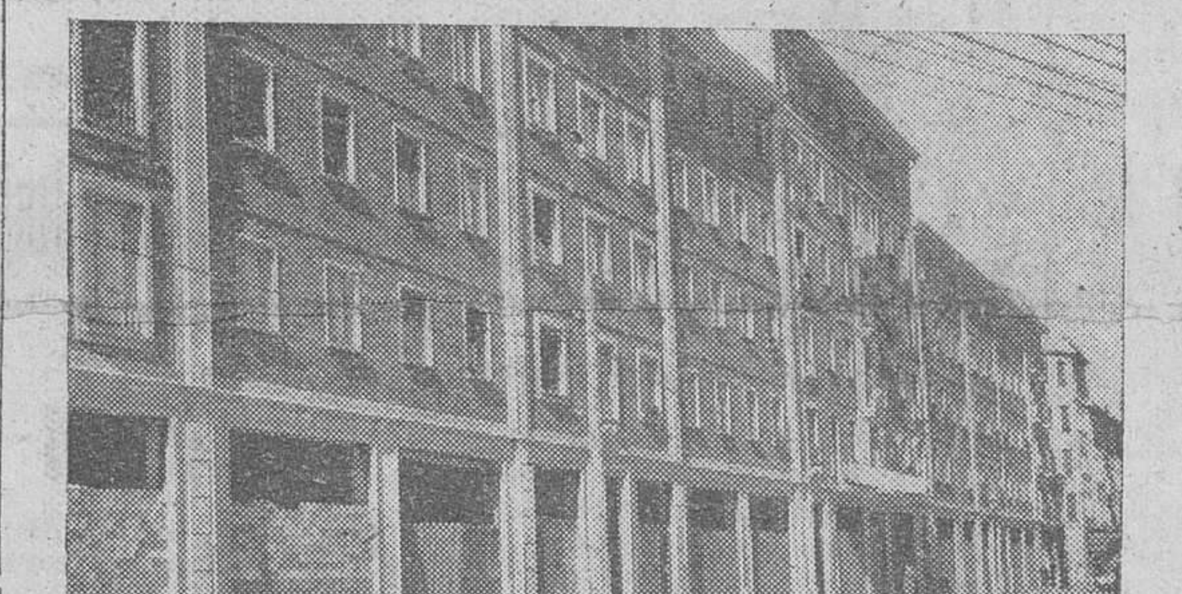
Grupo de viviendas enclavadas en la antigua «Barriada Obrera», que fueron entregadas en el mes de Abril
