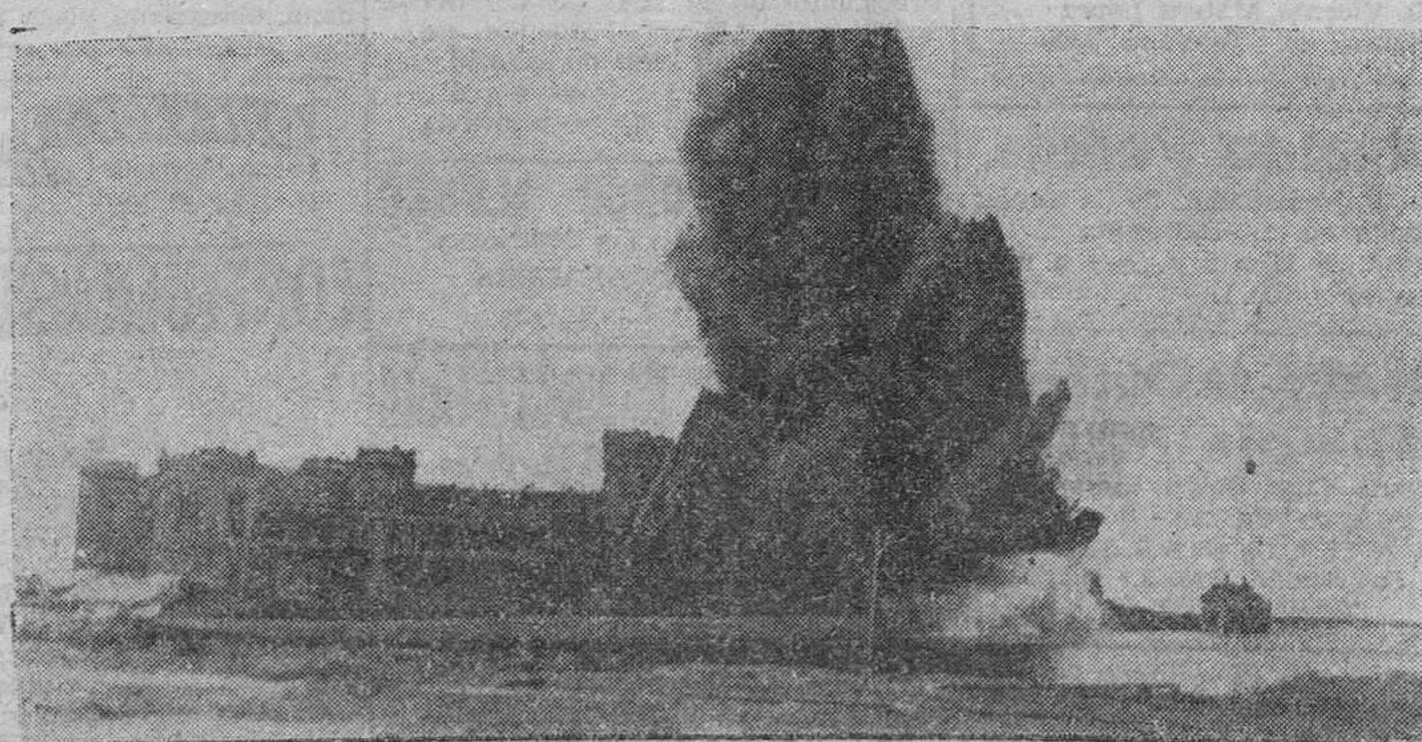
He aquí una fotografía interesante de la voladura de las instalaciones del puerto de Cherburgo llevada a cabo por los alemanes antes de su ocupación por los aliados
