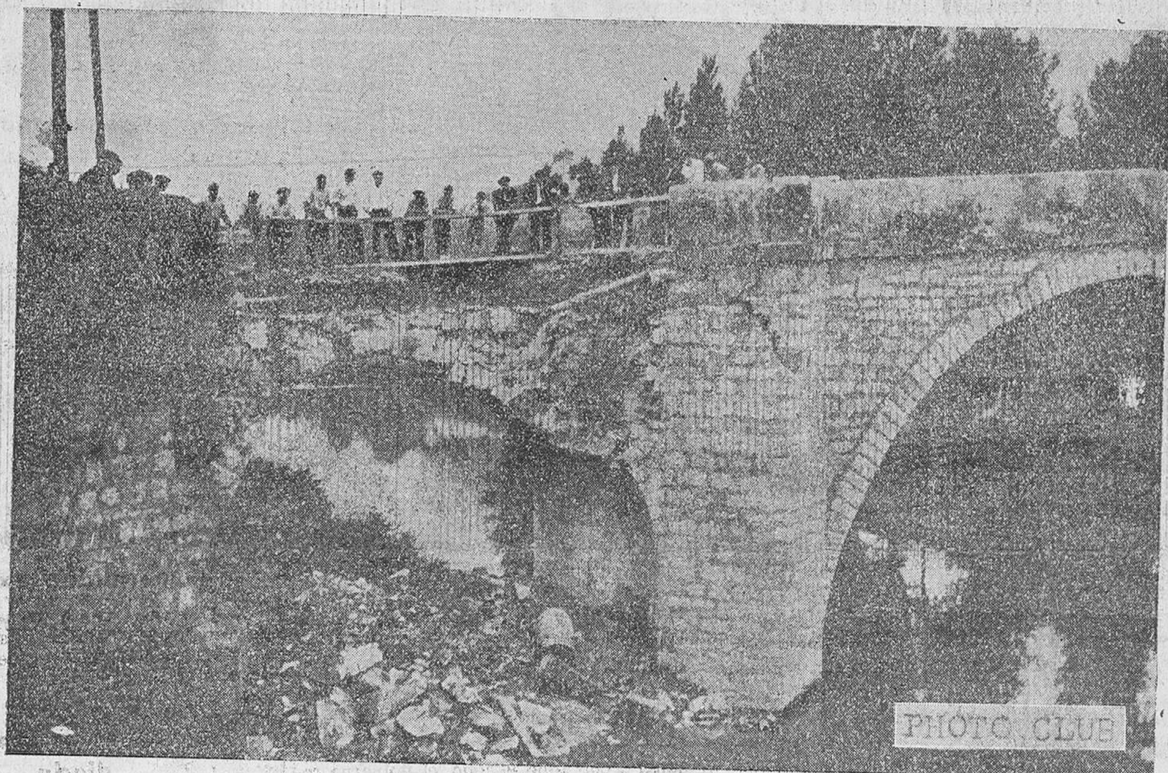
Este puente fué volado por los rojos y arreglado provisionalmente por nuestras tropas
