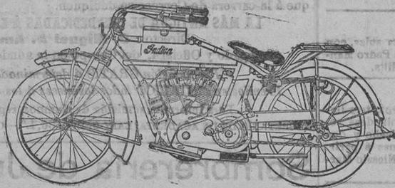
**Motocicletas INDIAN. — La mejor del mundo.** Modelos de uno y dos cilindros, de 3 1/2, 4, 5 y 7 H.P. y de tipo Honda Special, con arranque, alumbrado y klaxon eléctrico, contador kilométrico e indicador de velocidad.
