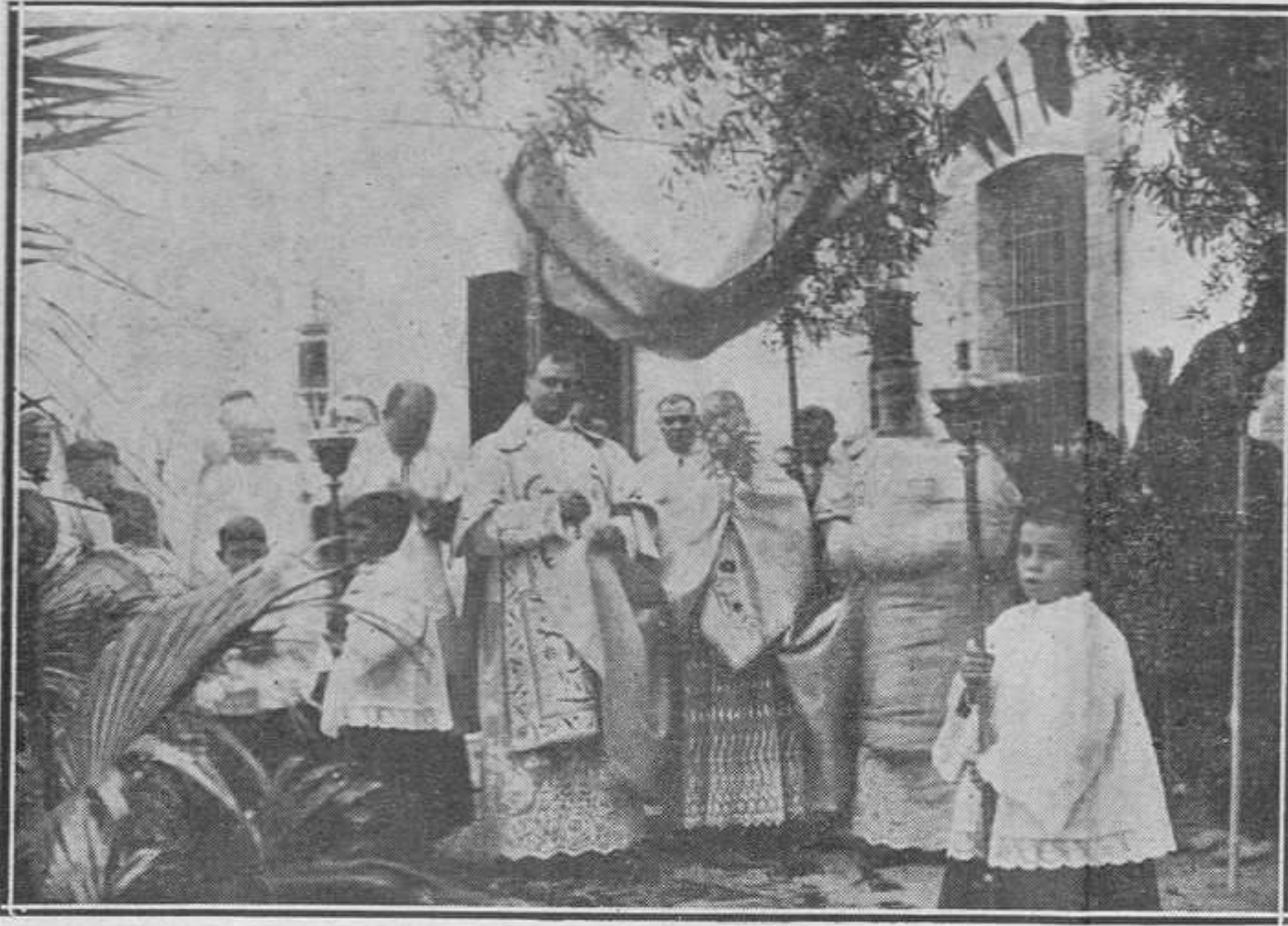
Solemne traslado del Santísimo Sacramento del antiguo Pabellón de las Religiosas al Pabellón nuevo
