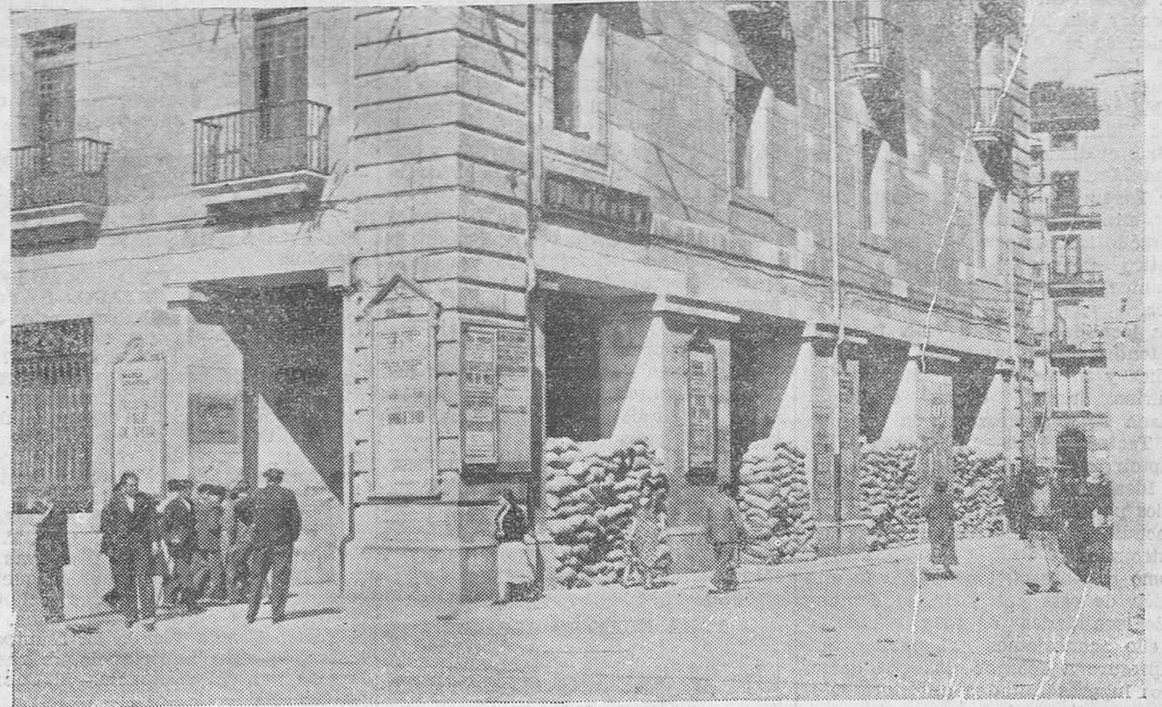
CONTRA LA AVIACION FACCIOSA. — En Santander se están instalando refugios contra los ataques aéreos. Algunos arcos se han cubierto con sacos terreros. (Foto Samot.)
