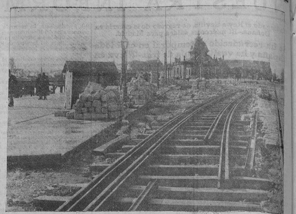
CONSECUENCIAS DE UN PLEITO.—He aquí el estado en que se encuentran en el puerto el tendido de nuevas vías, cuyos trabajos fueron paralizados debido al litigio que sostiene con la Junta de Obras del Puerto el contratista de las obras. ¡No sería posible que aquella Junta, sin perjuicio del resultado del pleito, continuara las obras, para evitar tan lamentable espectáculo! (Foto Samolá)
