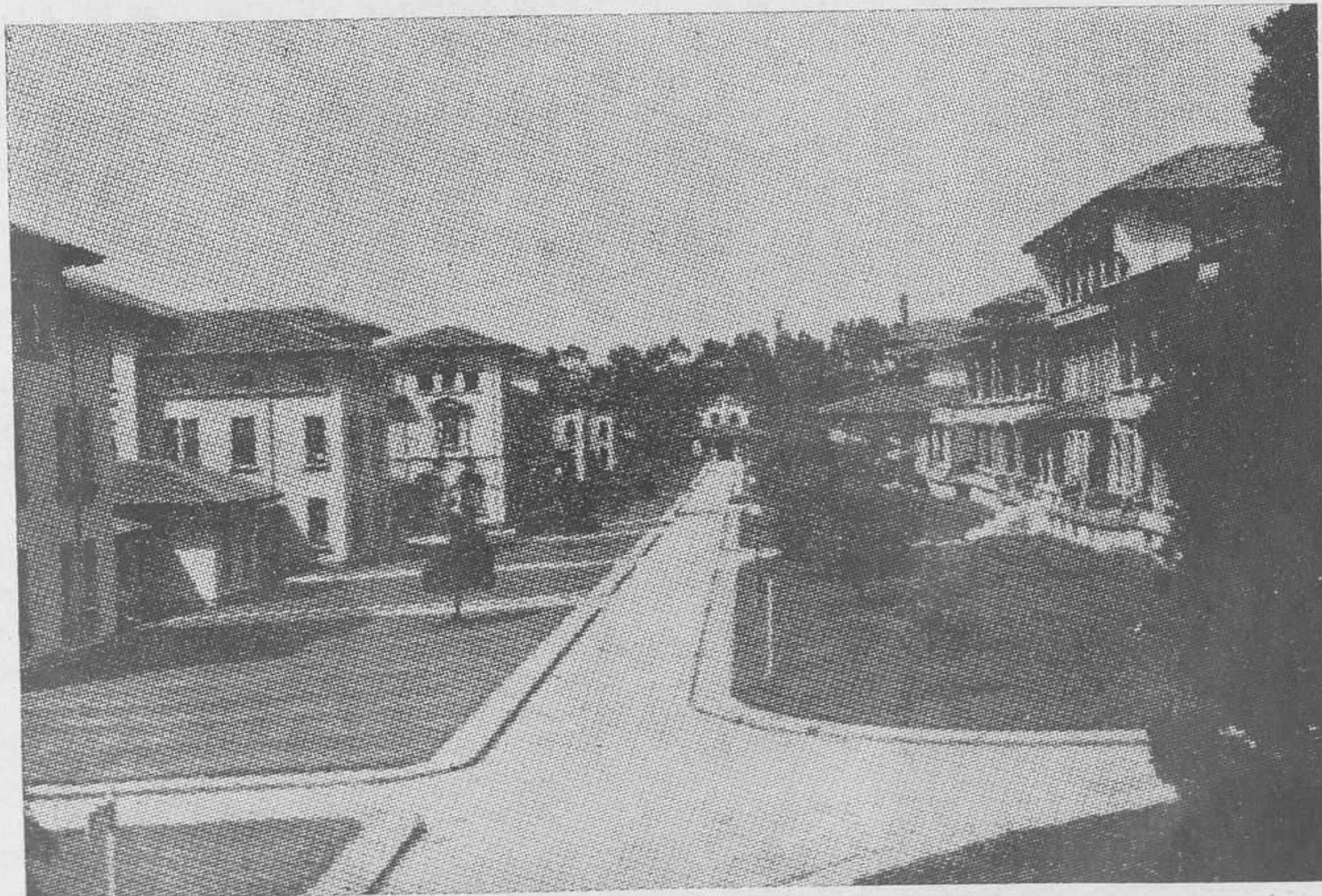
Casa de Salud Valdecilla. Una de las calles. A las derecha, pabellones de Beneficencia, y a su izquierda, los privados, teniendo por fondo la Capilla.
