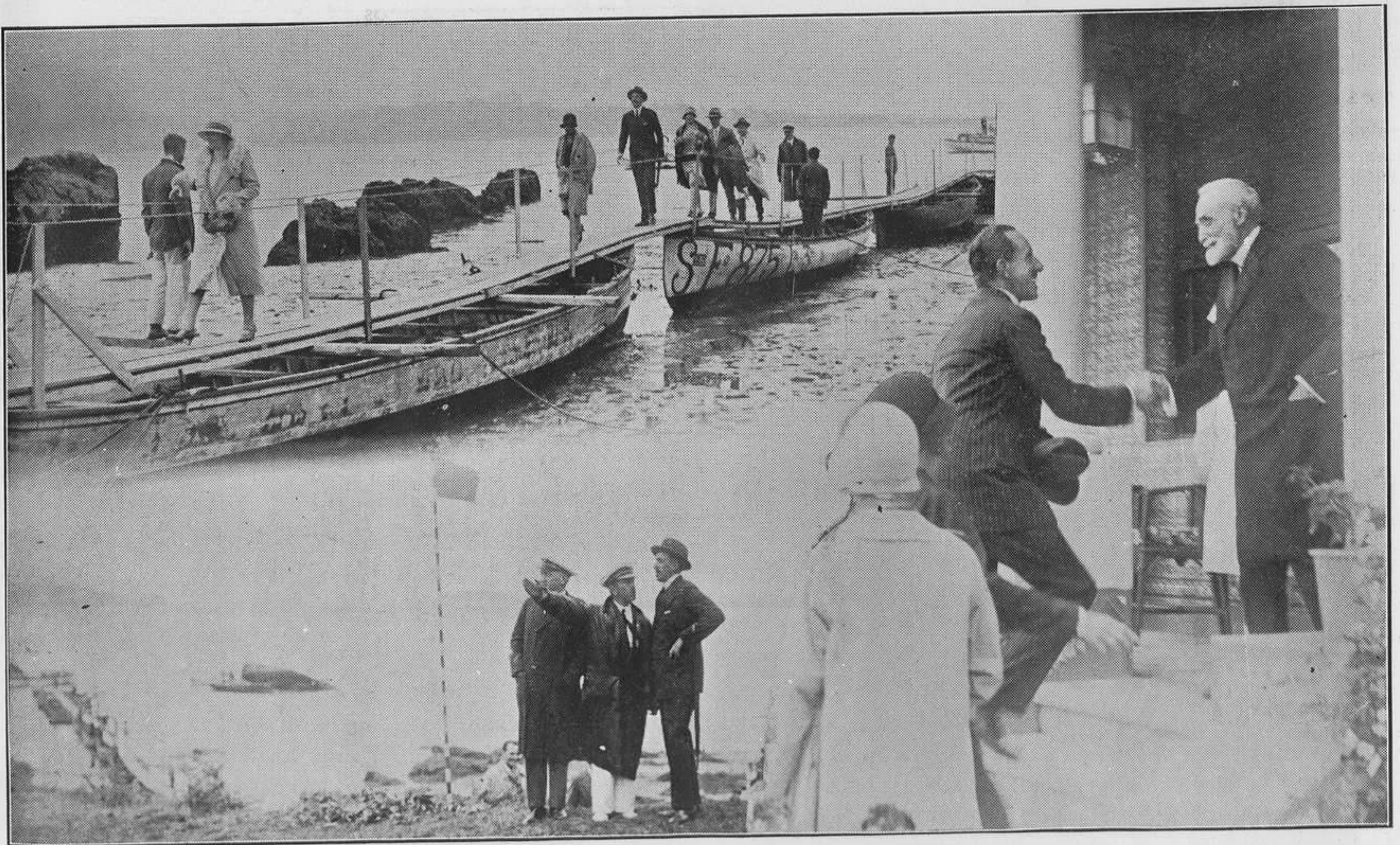
Los Reyes, durante la pasada temporada veraniega, desembarcando en Pedreña, para visitar el lugar donde hoy se está construyendo el campo de Golf que ha de inaugurarse este verano. A la derecha, el Rey don Alfonso saludando al marqués de Valdecilla.
