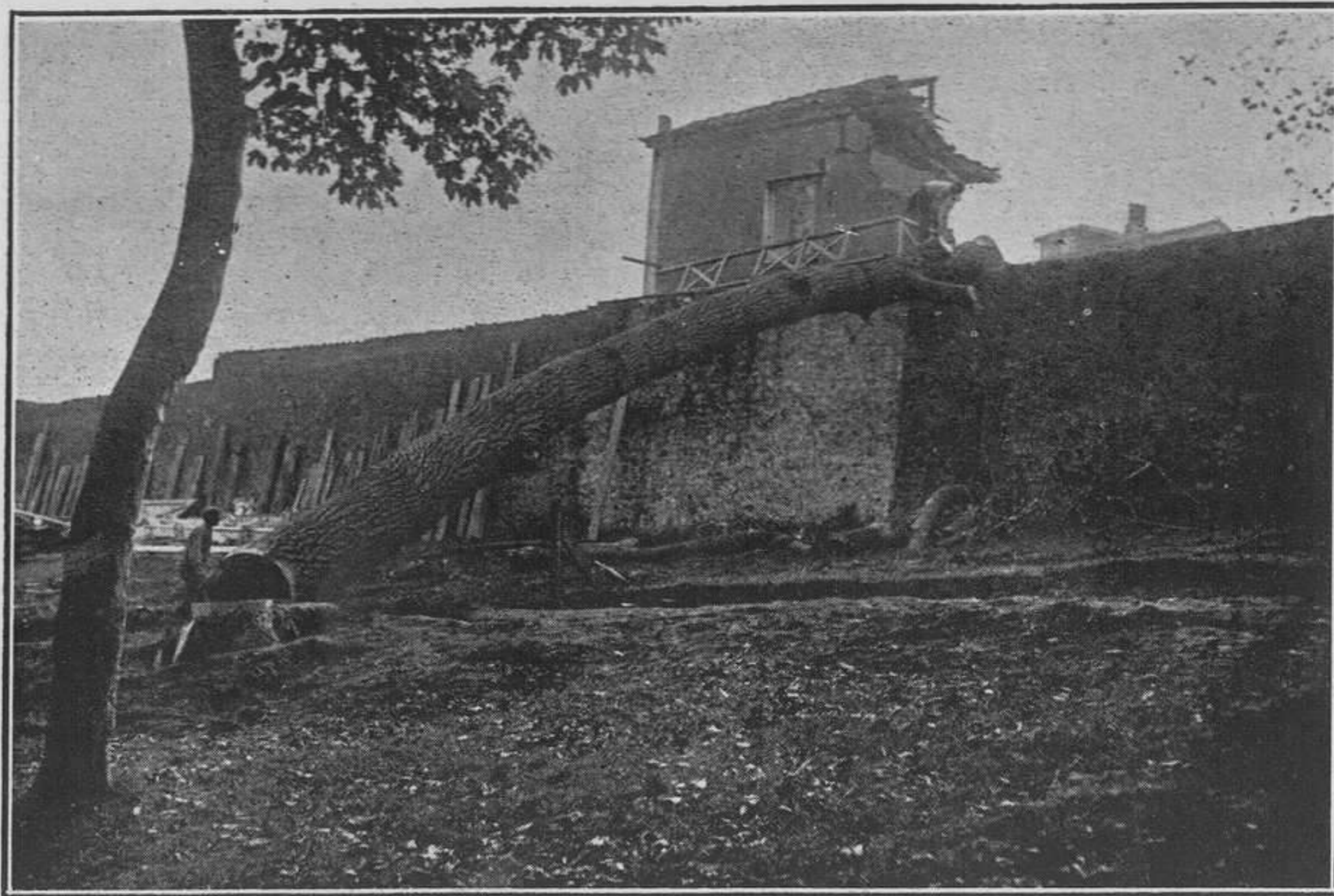
SANTANDER.—Arbol que cayó sobre la casa del señor Revolledo, destruyéndola.
