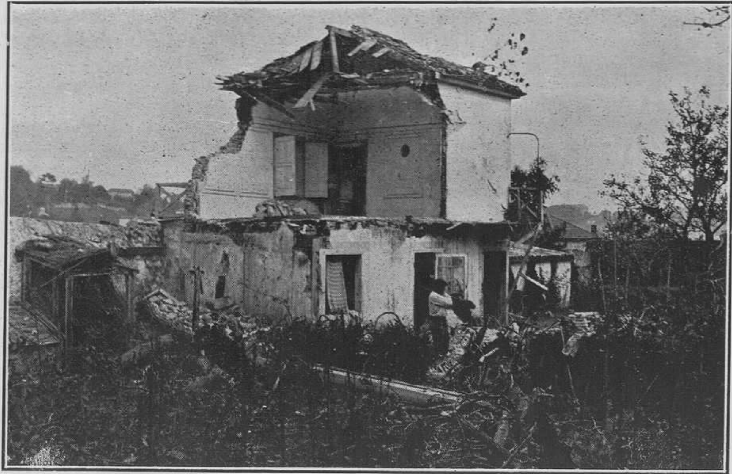
SANTANDER.—Estado en que quedó la casa después del accidente.
