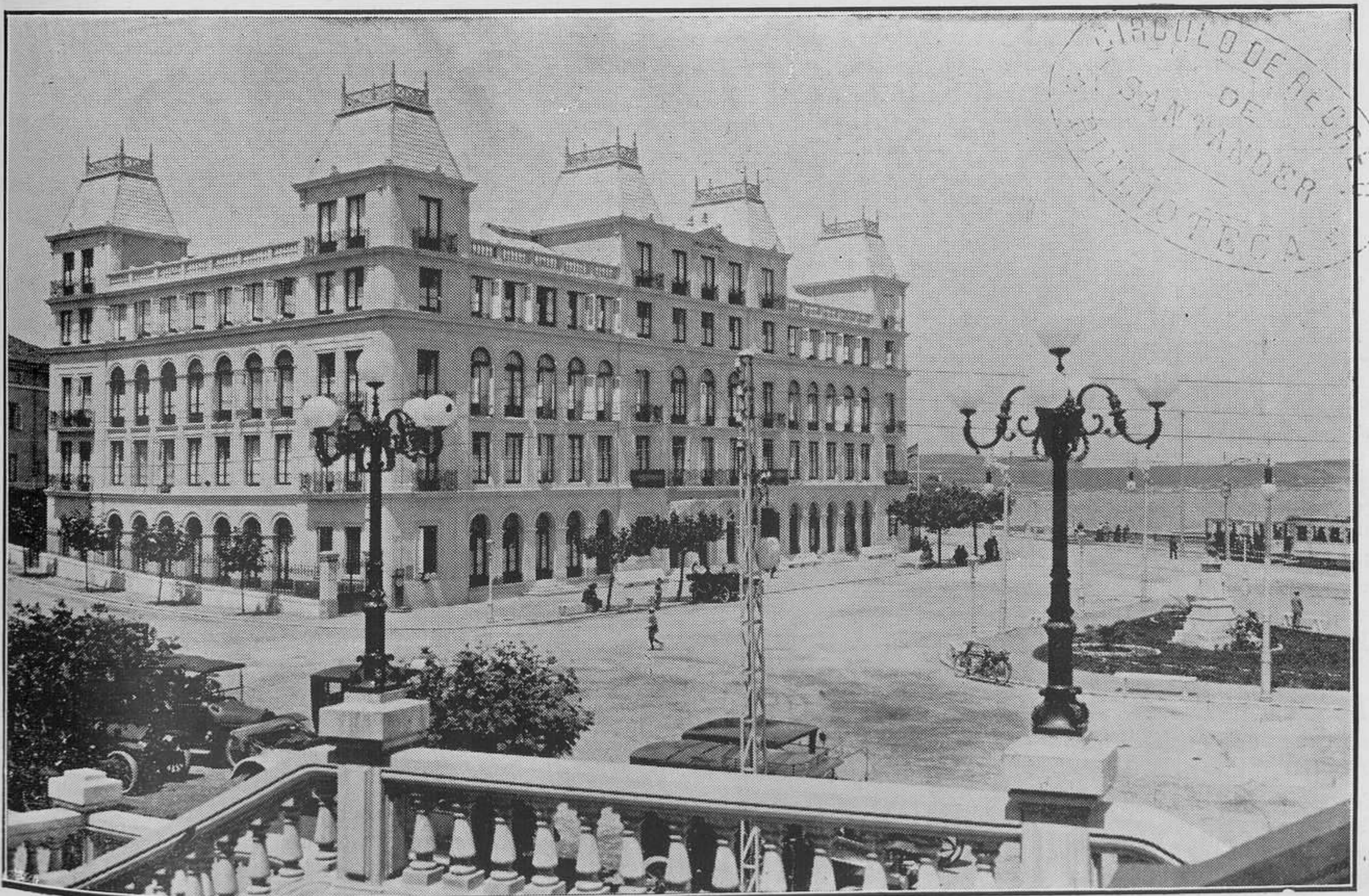
EL SARDINERO.—El Gran Hotel, transformado
