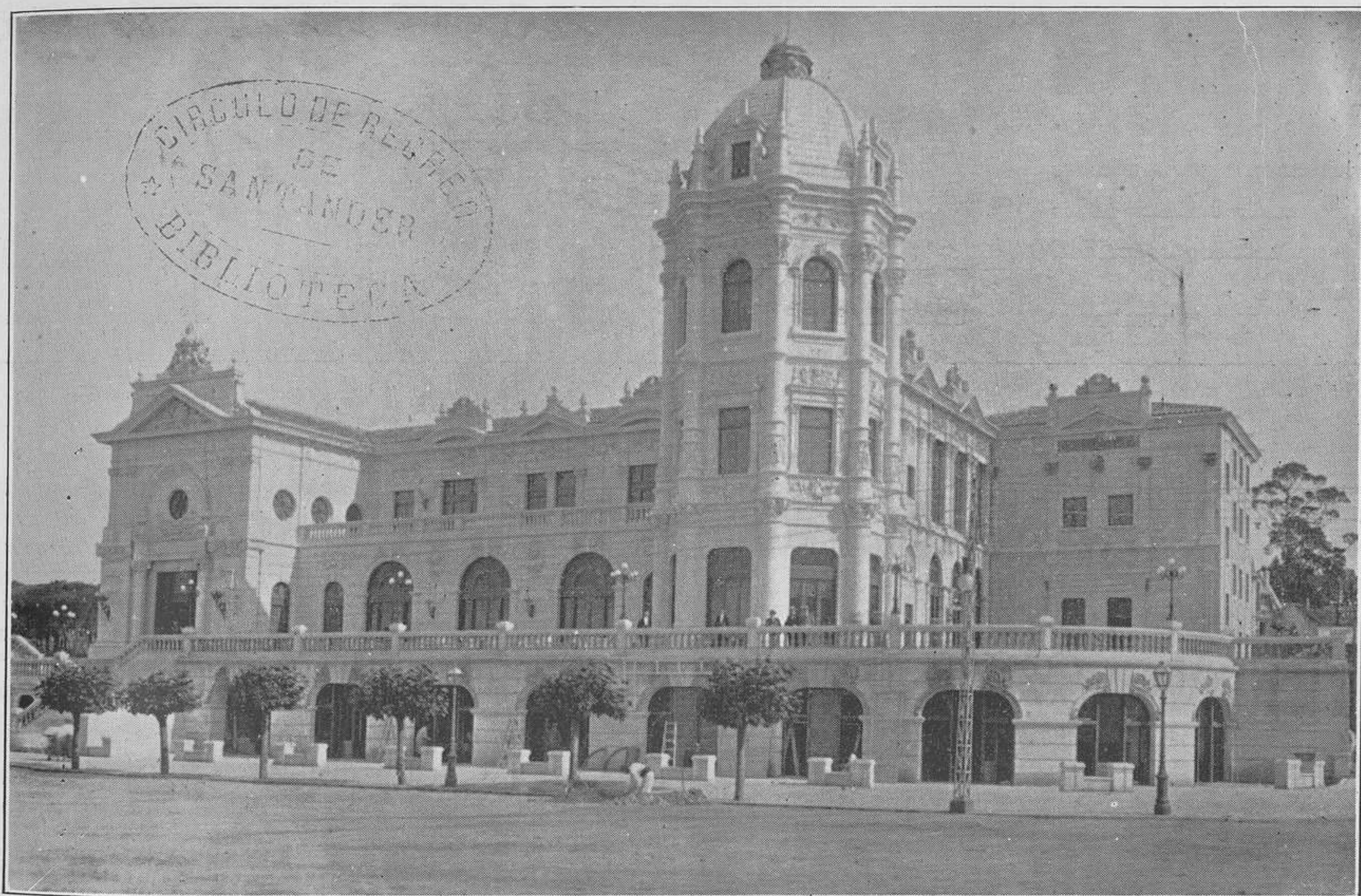
Vista parcial del edificio, del que falta otro cuerpo igual a éste
