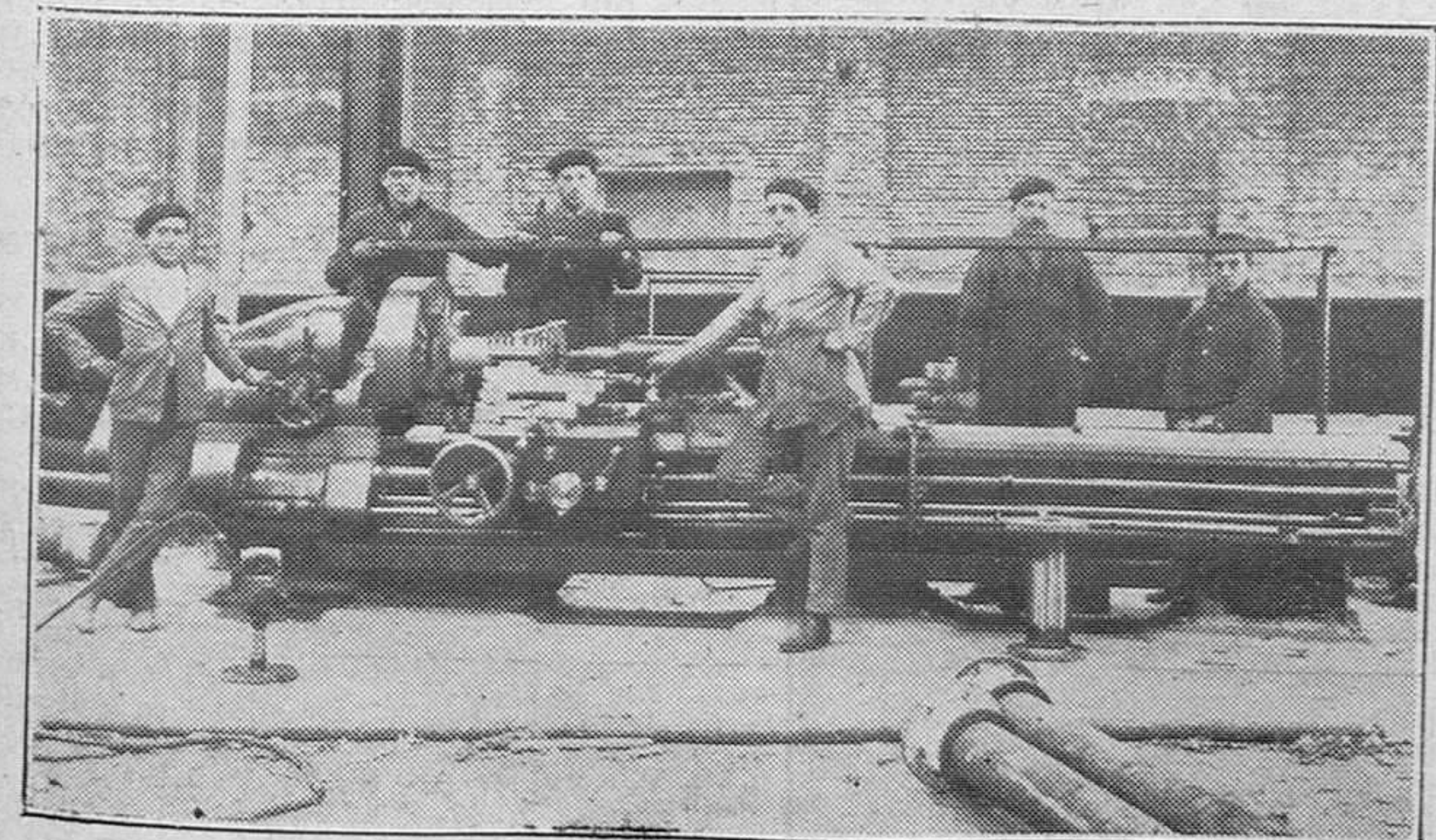
Uno de los diversos tornos monumentales, recientemente montado.
