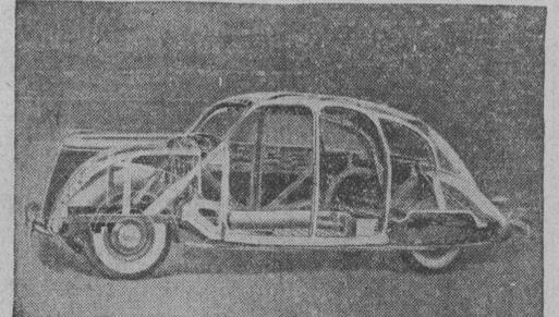
El armazon todo hecho de acero del Lincoln-Zephyr es rígido, todo soldado electricamente de arriba hacia abajo y por todas partes, proporcionando seguridad y largo uso al dueño.
