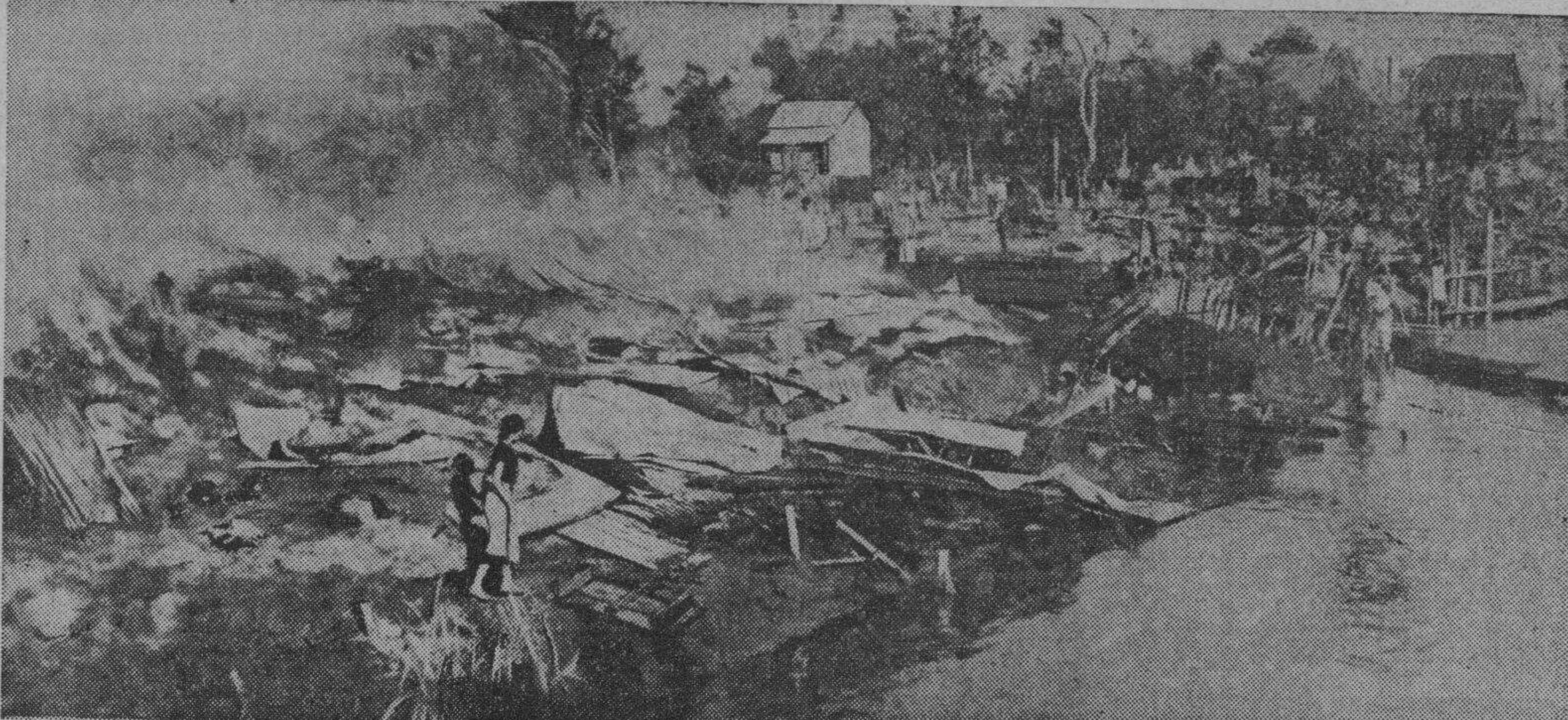
Parte de la zona destruida por un incendio en dos barrios de Hagonoy, Bulacan, en la madrugada de ayer. Numerosas casas, incluyendo una aserradora de Dy Chua Kang, el almacén de Carmen Saguisin y otras de materiales fuertes, fueron destruidas por el fuego. Los daños totales se calculan en P100,000.
