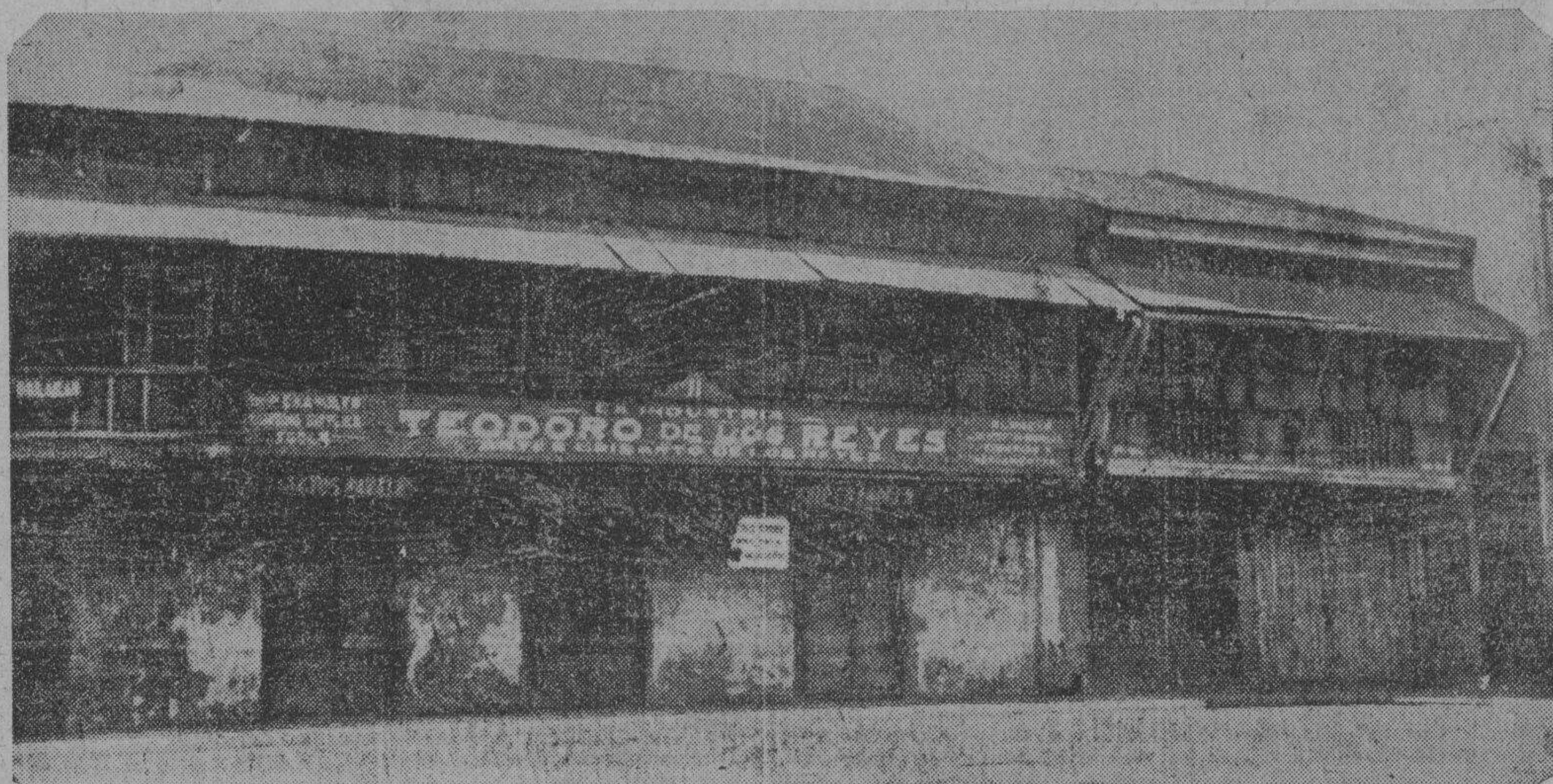
El viejo caseron de madera del Sr. Geronimo de los Reyes, poco antes de ser demolido. En su lugar, en la Plaza Cervantes, se yergue ahora el nuevo Edificio de los Reyes.
