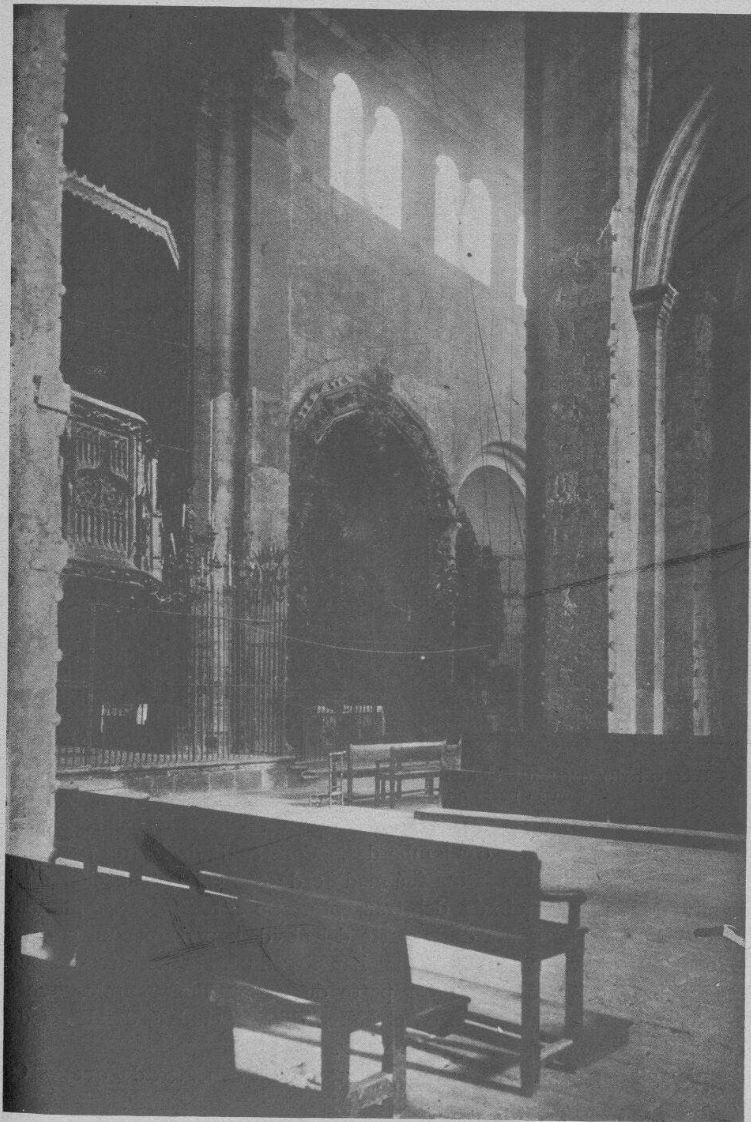
Interior de la Catedral. Parte del crucero restaurado.
