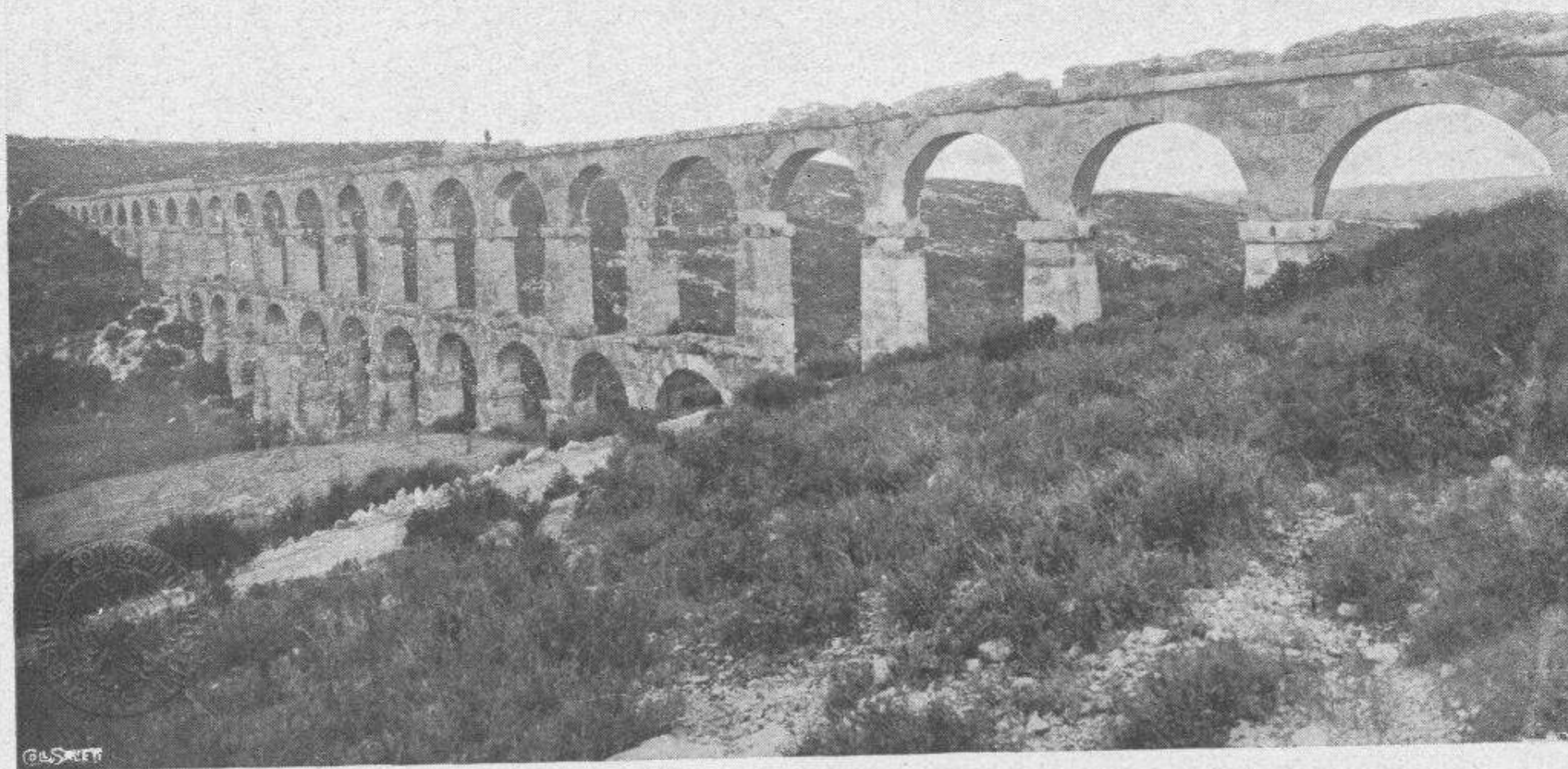
Vista general del acueducto. — Vue générale de l'aqueduc.
