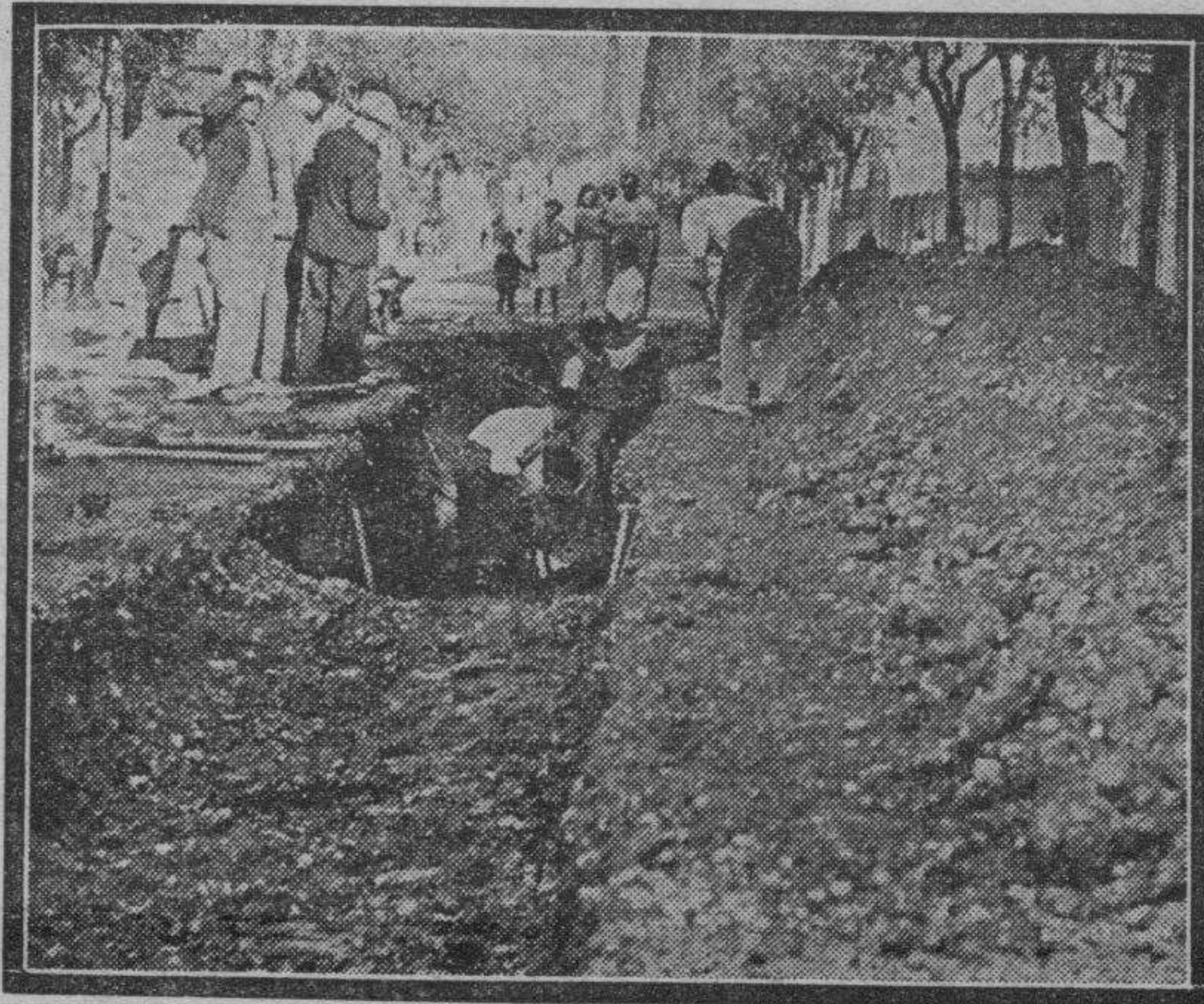
Los obreros municipales abriendo una zanja en la Avenida de las Delicias, después de la rotura de la tubería general.
