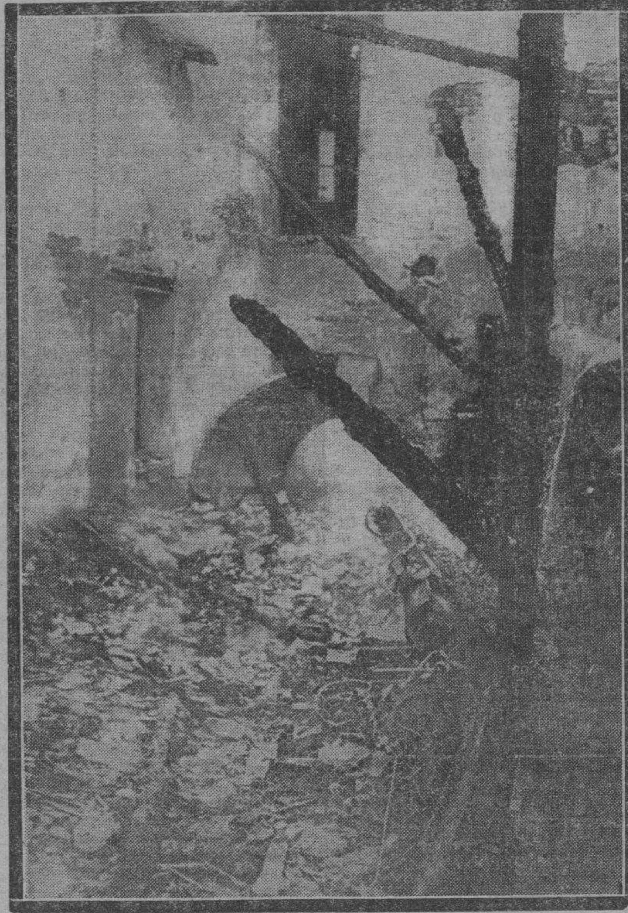
Un aspecto del edificio que fué pasto de las llamas durante la madrugada del jueves en la calle del Arrabal, término de Valimaña.
