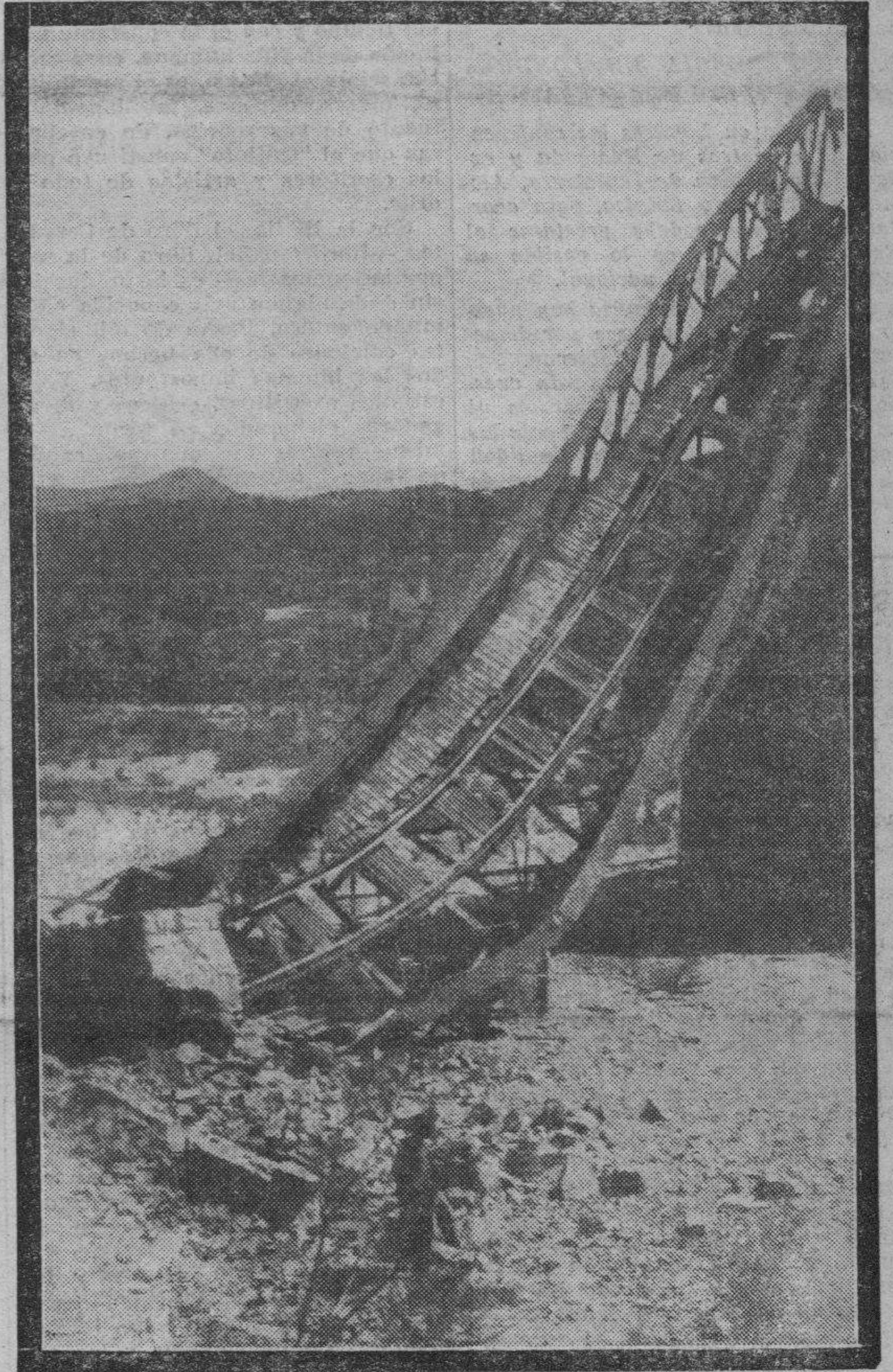
Estado en que quedó el puente de la línea M. Z. A. después del desprendimiento de tierras ocurrido entre las estaciones de Nonaspe y Fayón. El bloque de piedra que se observa en primer término tiene un peso aproximado de 32 toneladas.
