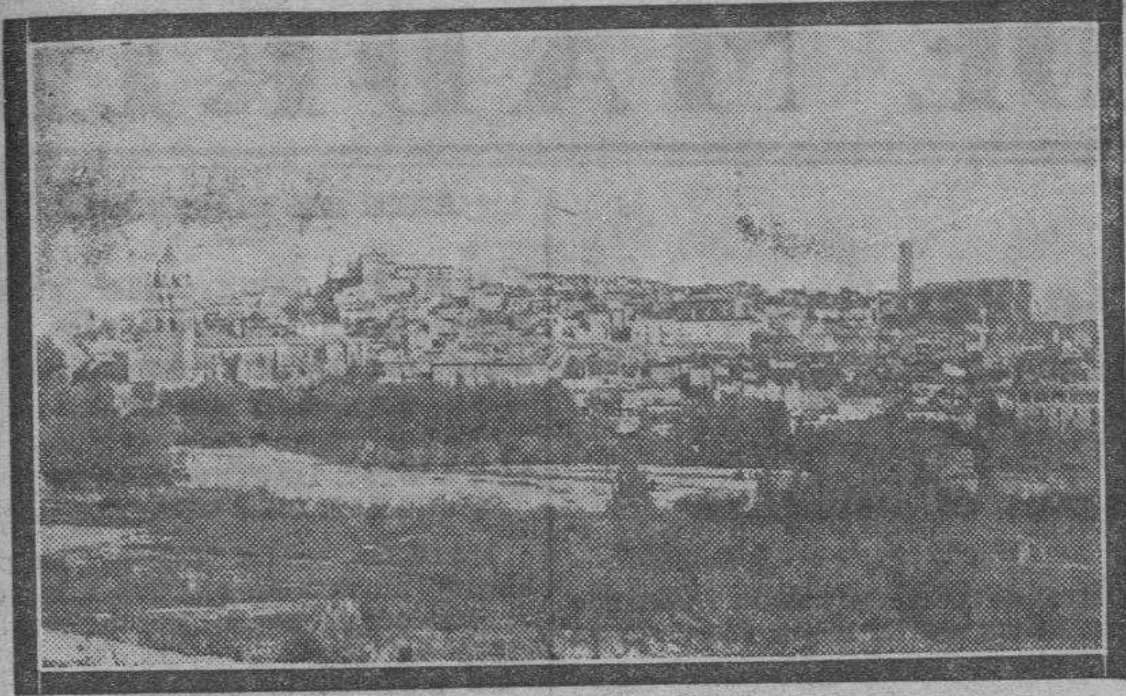
CALAHORRA. — Vista general.
