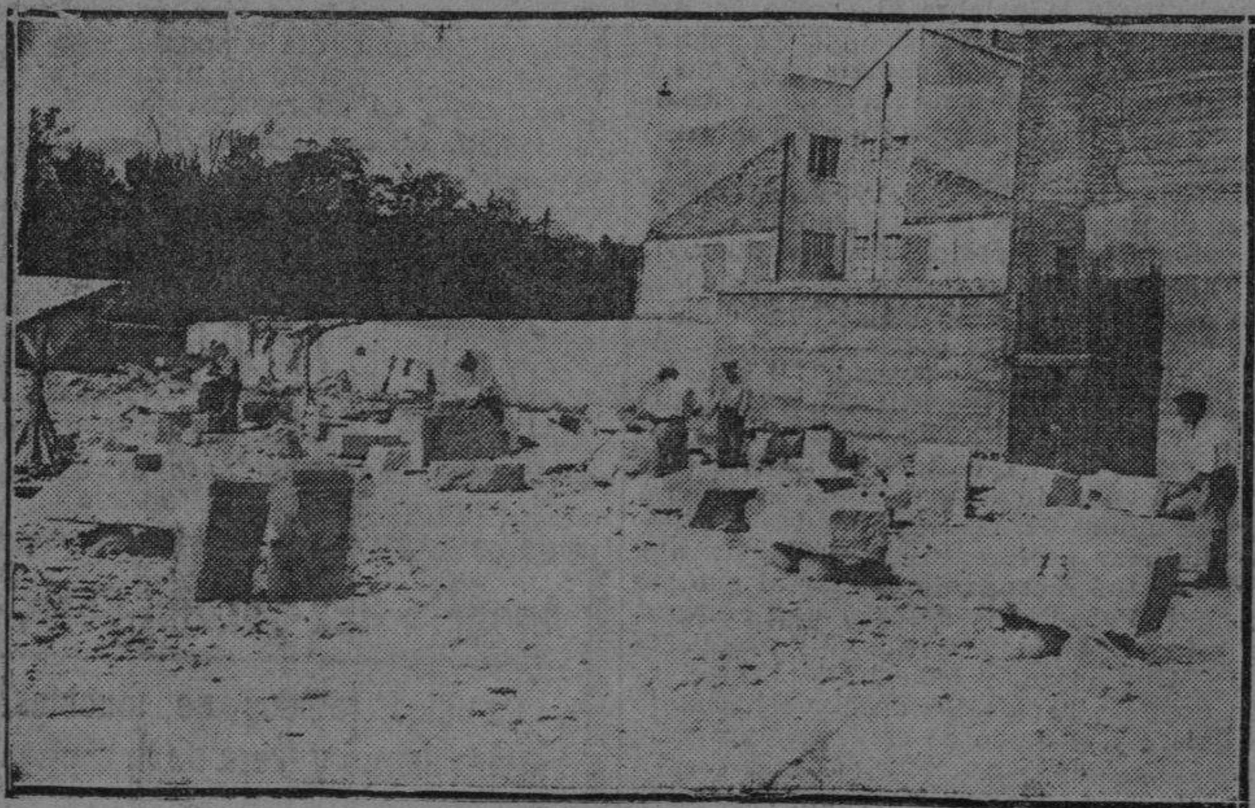
Vista general de un taller de cantería
