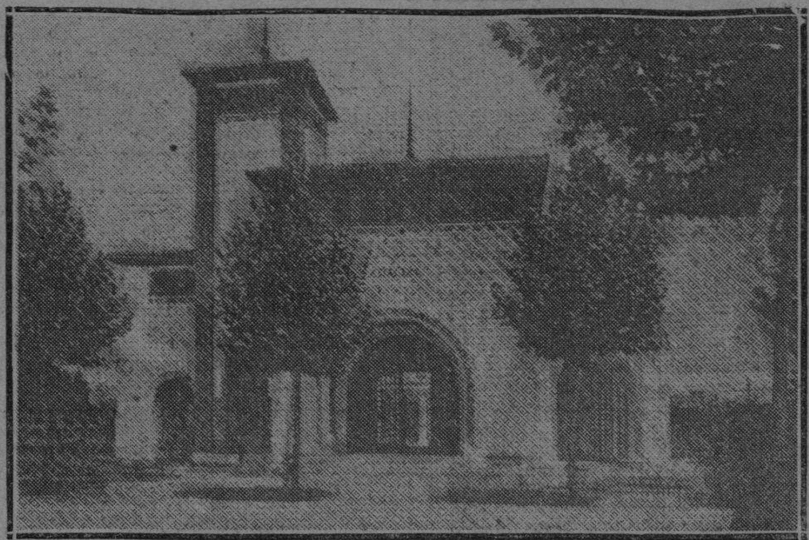
El pabellón aragonés que figura en la Exposición de Sevilla, cuyas obras están ya terminadas totalmente, y en espera de alojar «algo» de nuestra región
