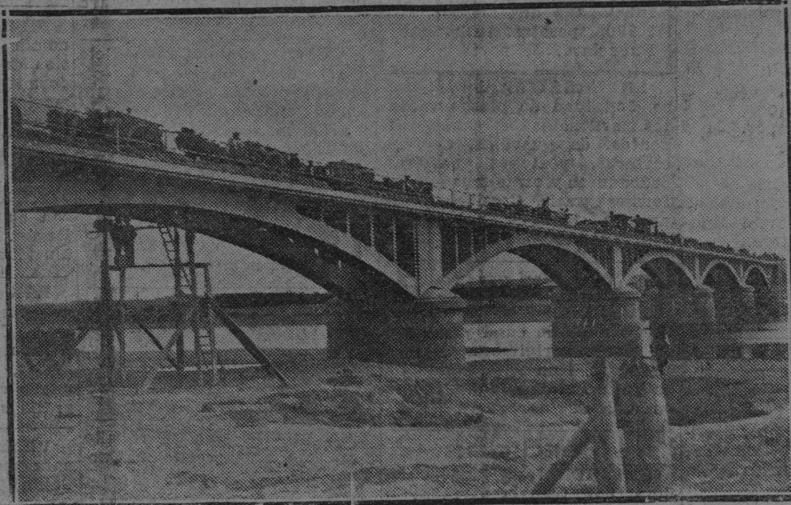
El nuevo puente sobre el Ebro, entre Rincón y Milagro, durante las pruebas de resistencia que se han verificado
