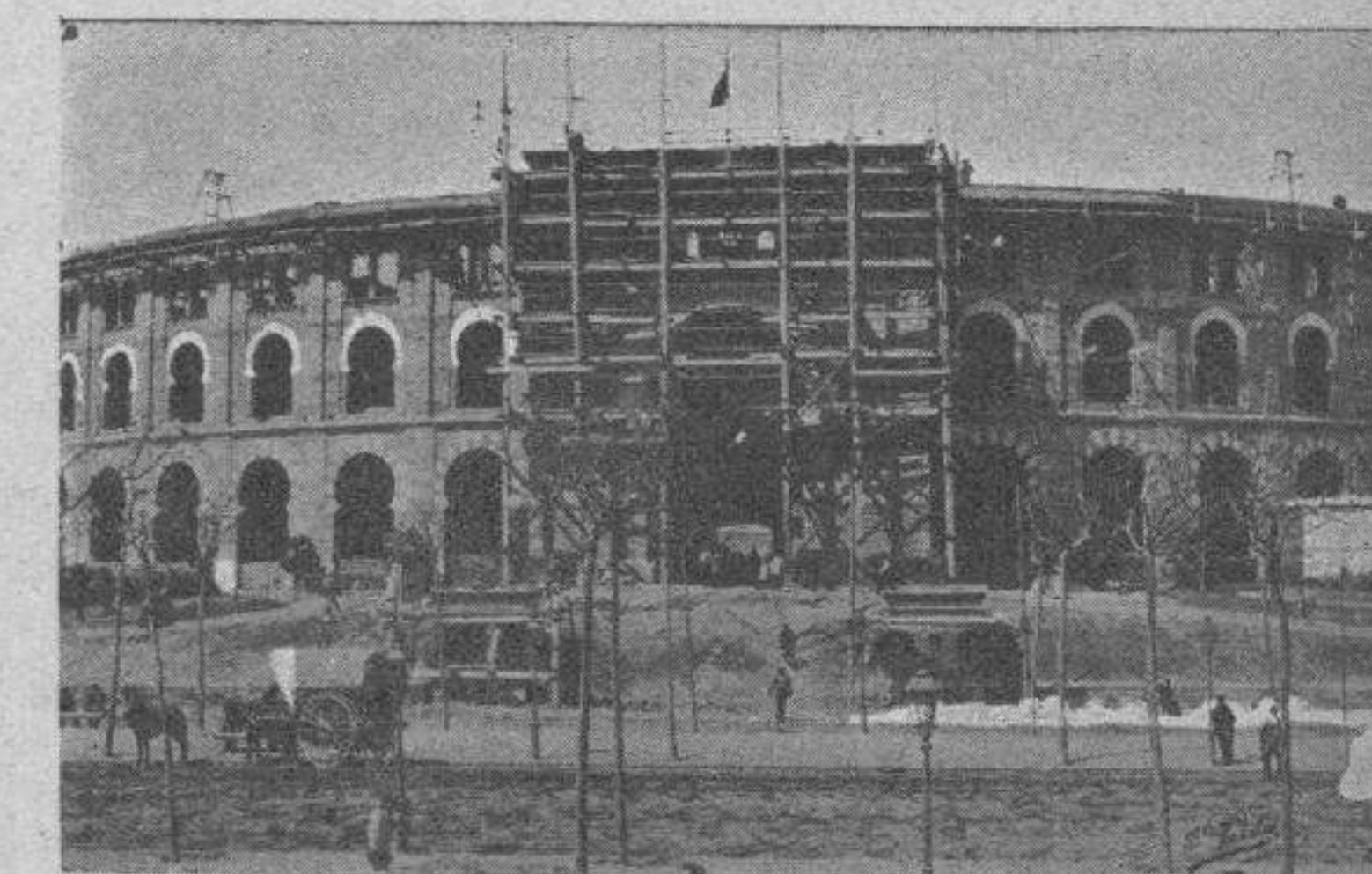
Abril de 1900.—Exterior de la puerta principal, á la altura de la cubierta.
