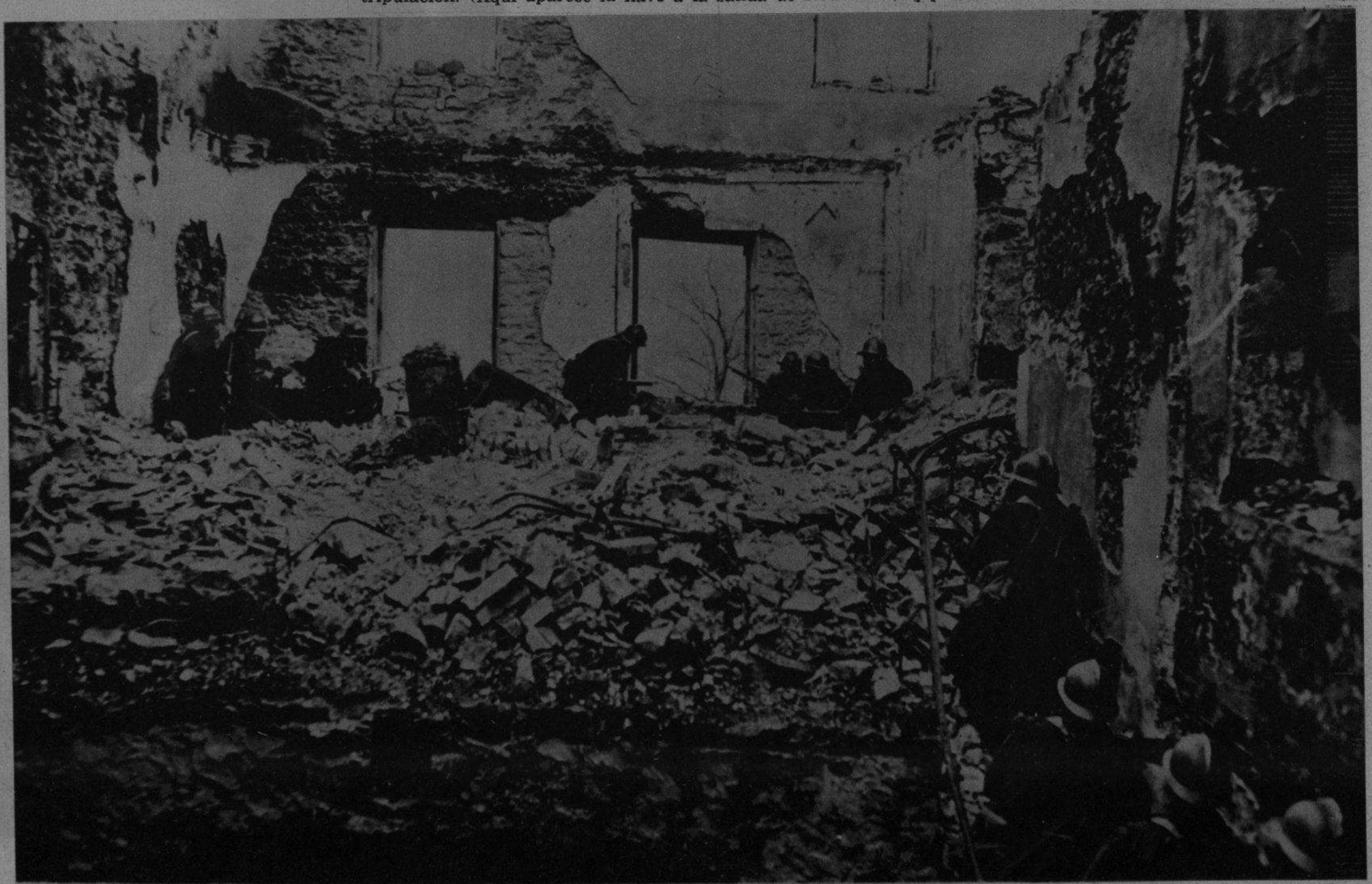
EN EL FRENTE OCCIDENTAL.—En las ruinas de una casa demolida por la artillería, estos soldados franceses se han parapetado defendiendo las líneas avanzadas del frente. (Foto Wide, censurada)
