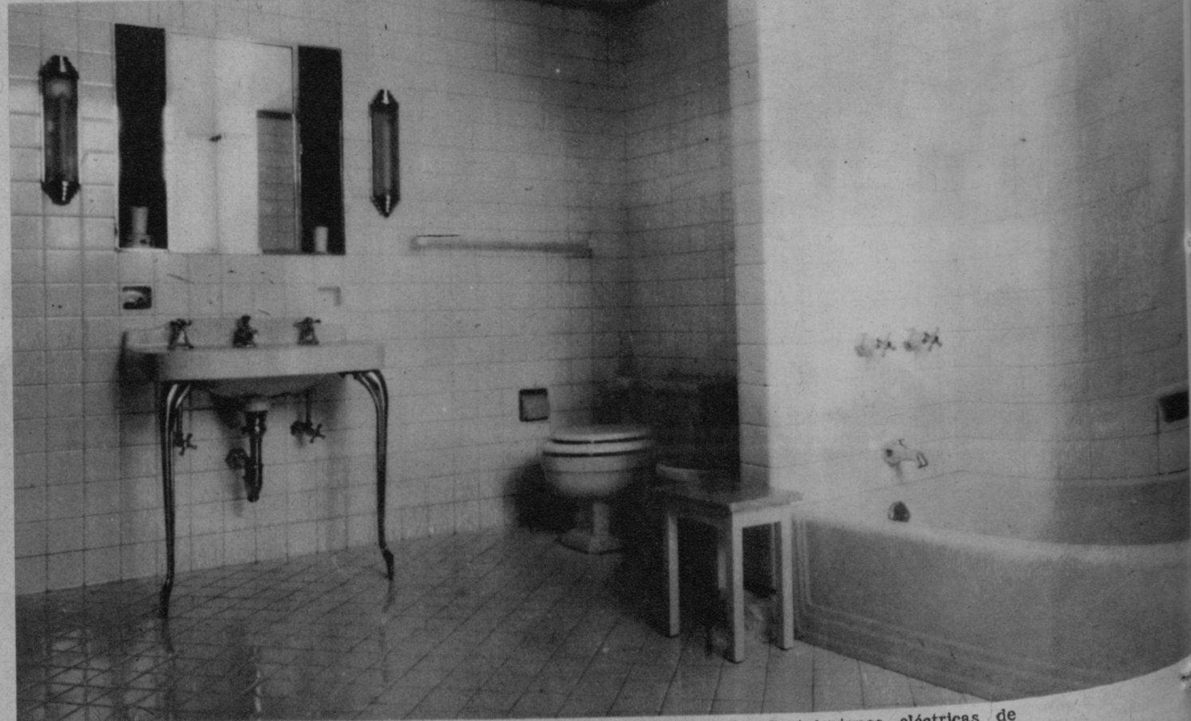
SERVICIO sanitario de la Casa Gancedo. Instalaciones eléctricas de Eduardo Albertus. Pisos sanitarios antirresbalables de Crespo y Co.
