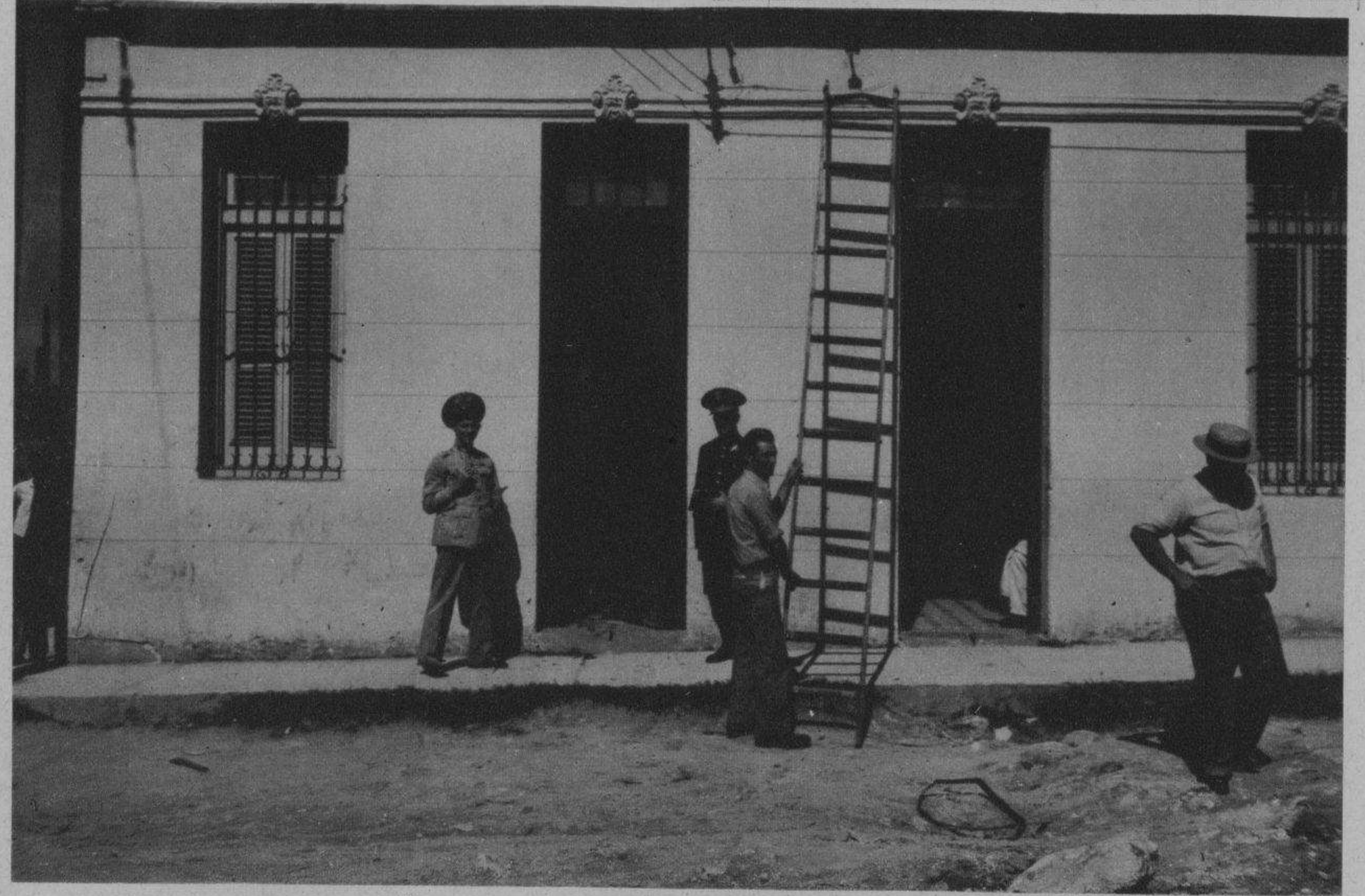
ESTA ES LA CASA situada en Arango y Luco (Luyanó) donde descubrió ayer la policía nacional una gran cantidad de explosivos. Se comprobó que tal existencia de dinamita no era sencillamente un depósito, sino una perfecta mina hecha para volar el inmueble. Los terroristas tenían la intención de atraer a la gente, cumpliendo sus siniestros designios de causar víctimas. Más la policía frustró sus propósitos, pues audazmente se incautó de la dinamita (Foto D. M.)
