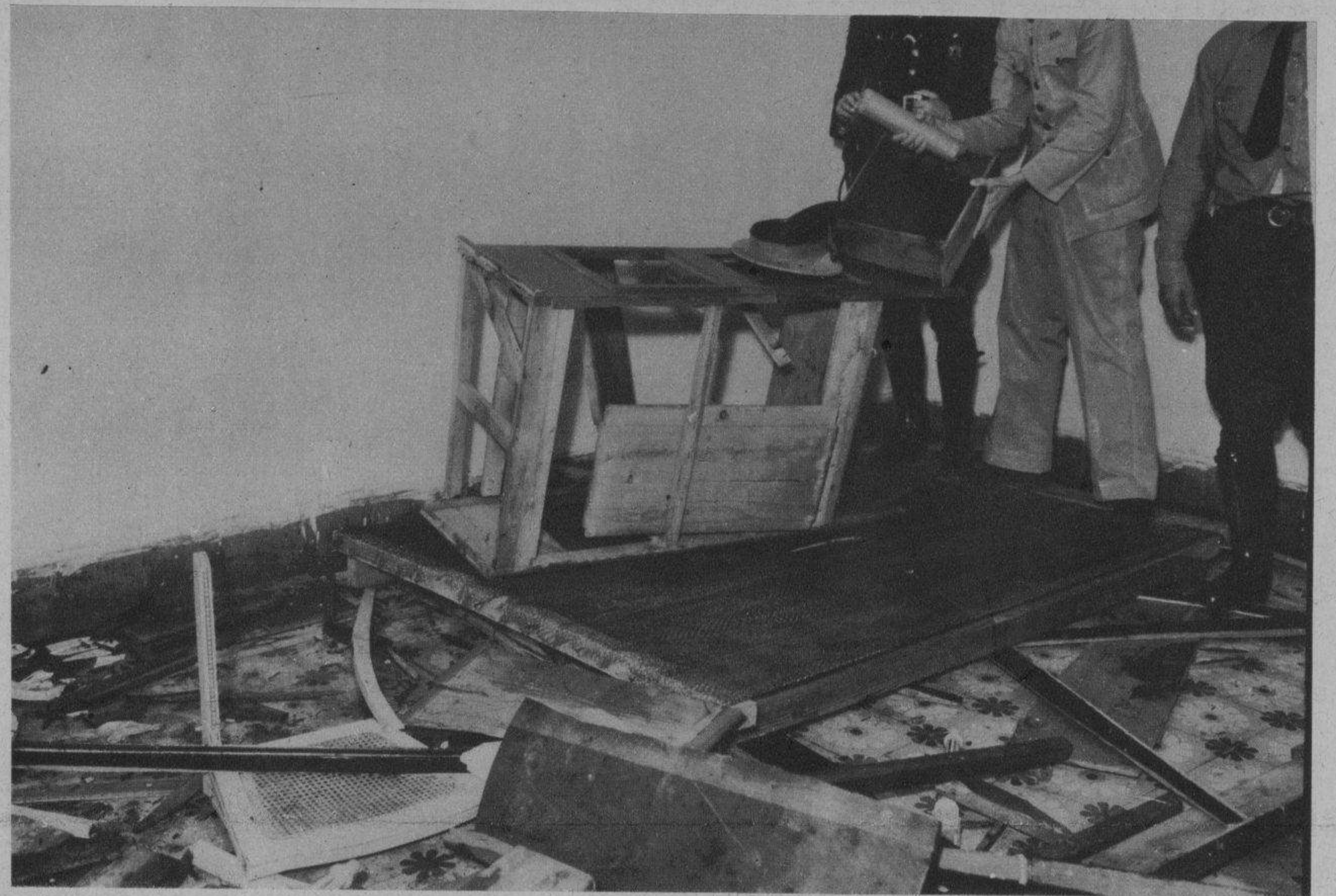
INTERIOR de la casa de la calle Arango y Luco (Luyanó), tal y como quedó después de la explosión del fulminante que debería producir la catástrofe prevista por los terroristas, evitada gracias al arrojo de la policía sustrayendo los numerosos cartuchos de dinamita (Foto D. M.)
