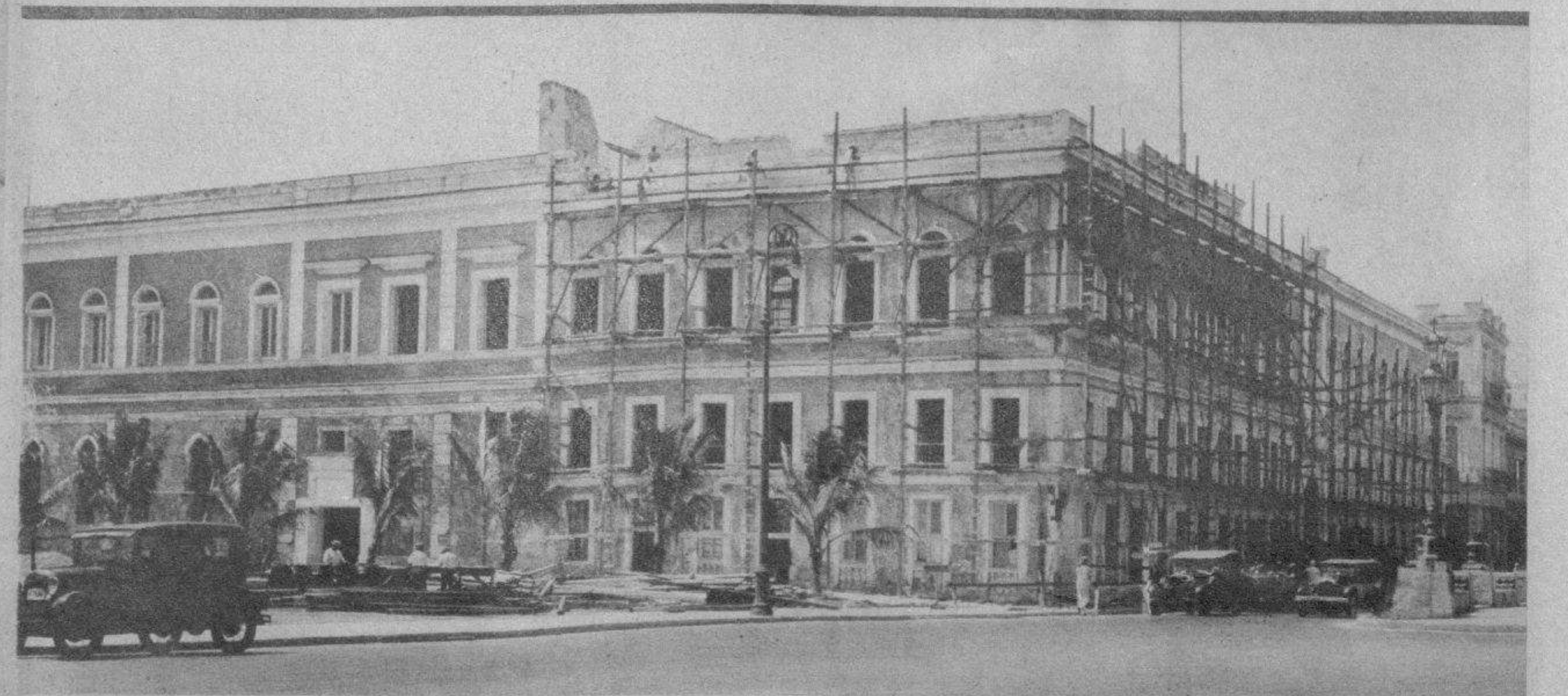
ESTADO de las obras de reconstrucción y embellecimiento del edificio en que se hallaba antes la Cárcel de la Habana. Se asegura que cuando la obra finiquite el palacio colonial será uno de los más bellos de esta capital (Foto D. M.)
