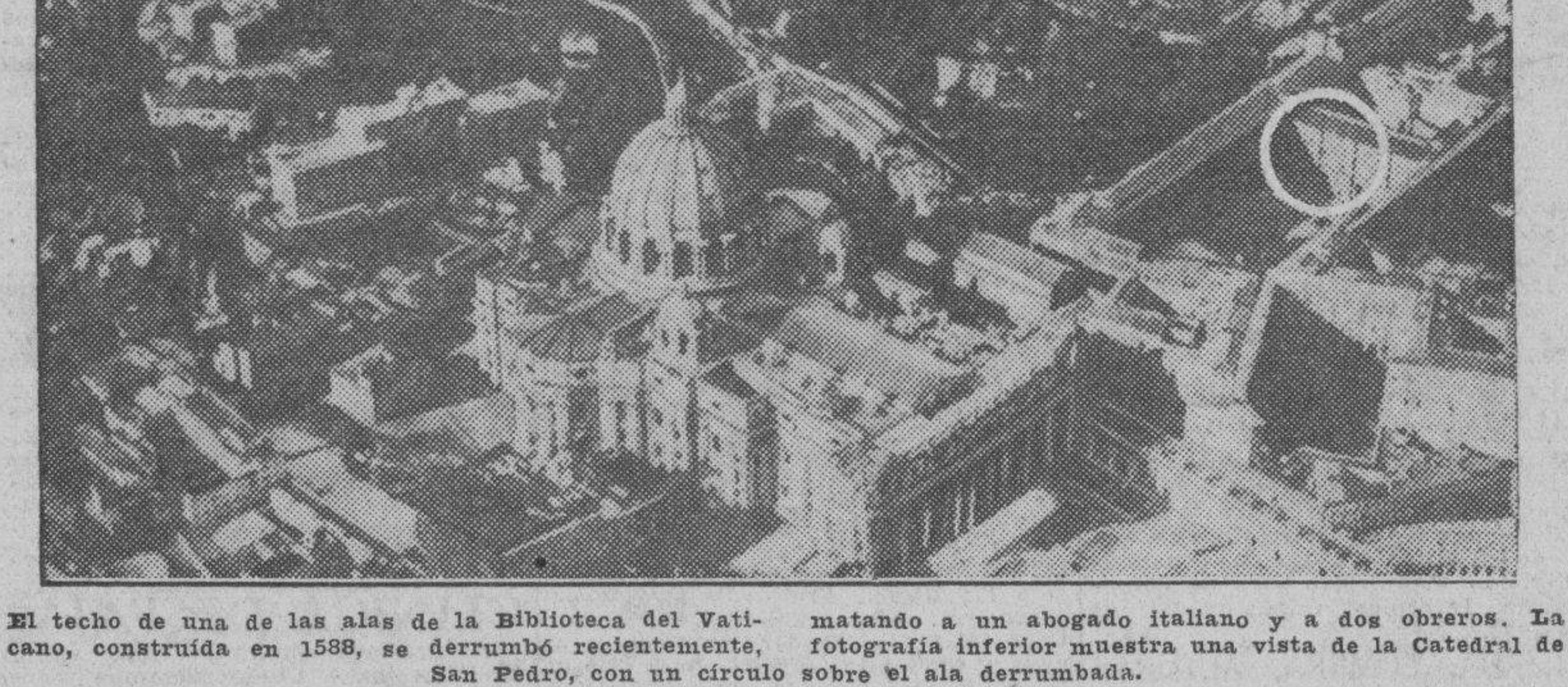
El techo de una de las alas de la Biblioteca del Vaticano, construida en 1588, se derrumbó recientemente...
