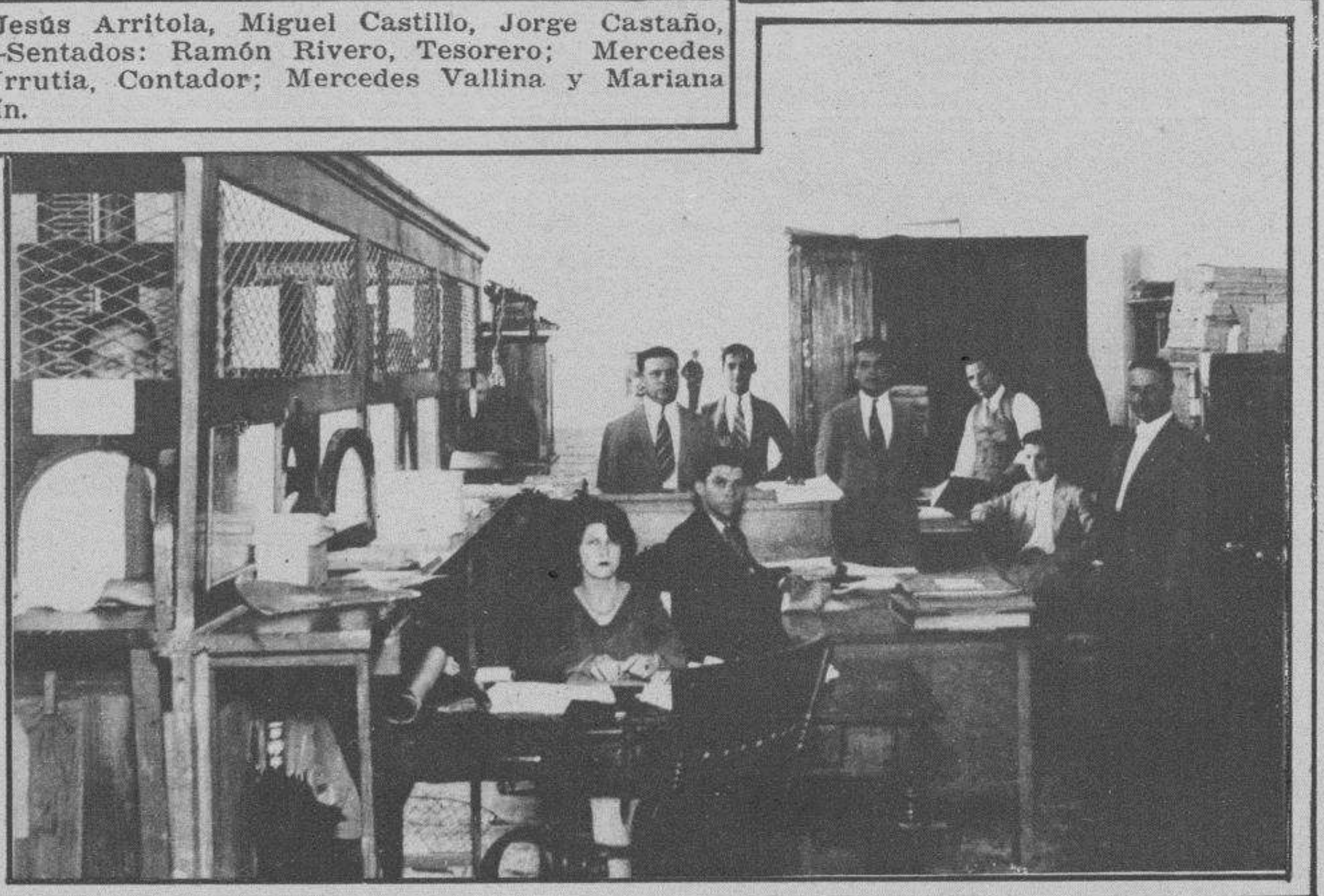
Aspecto de uno de los salones de las Oficinas.
