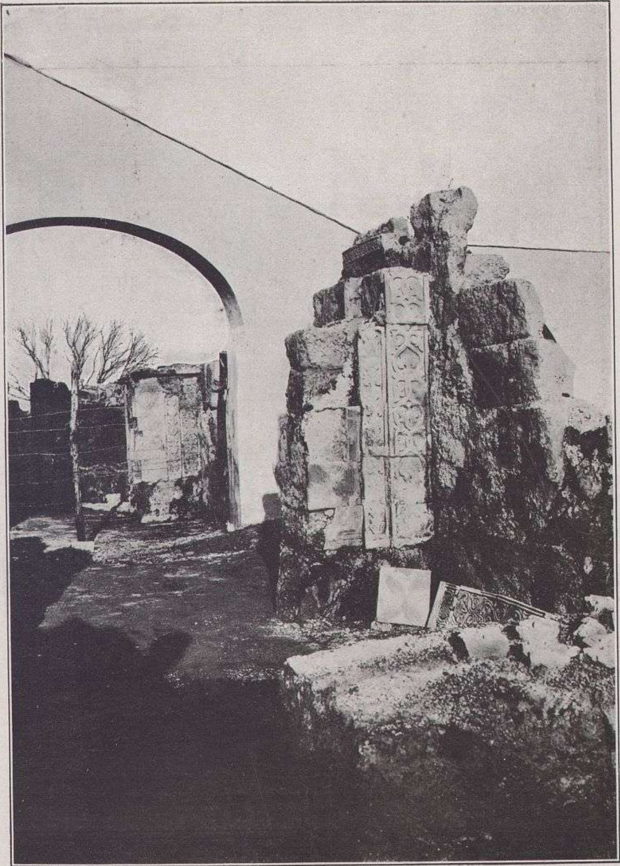
RESTOS DE CONSTRUCCIÓN
