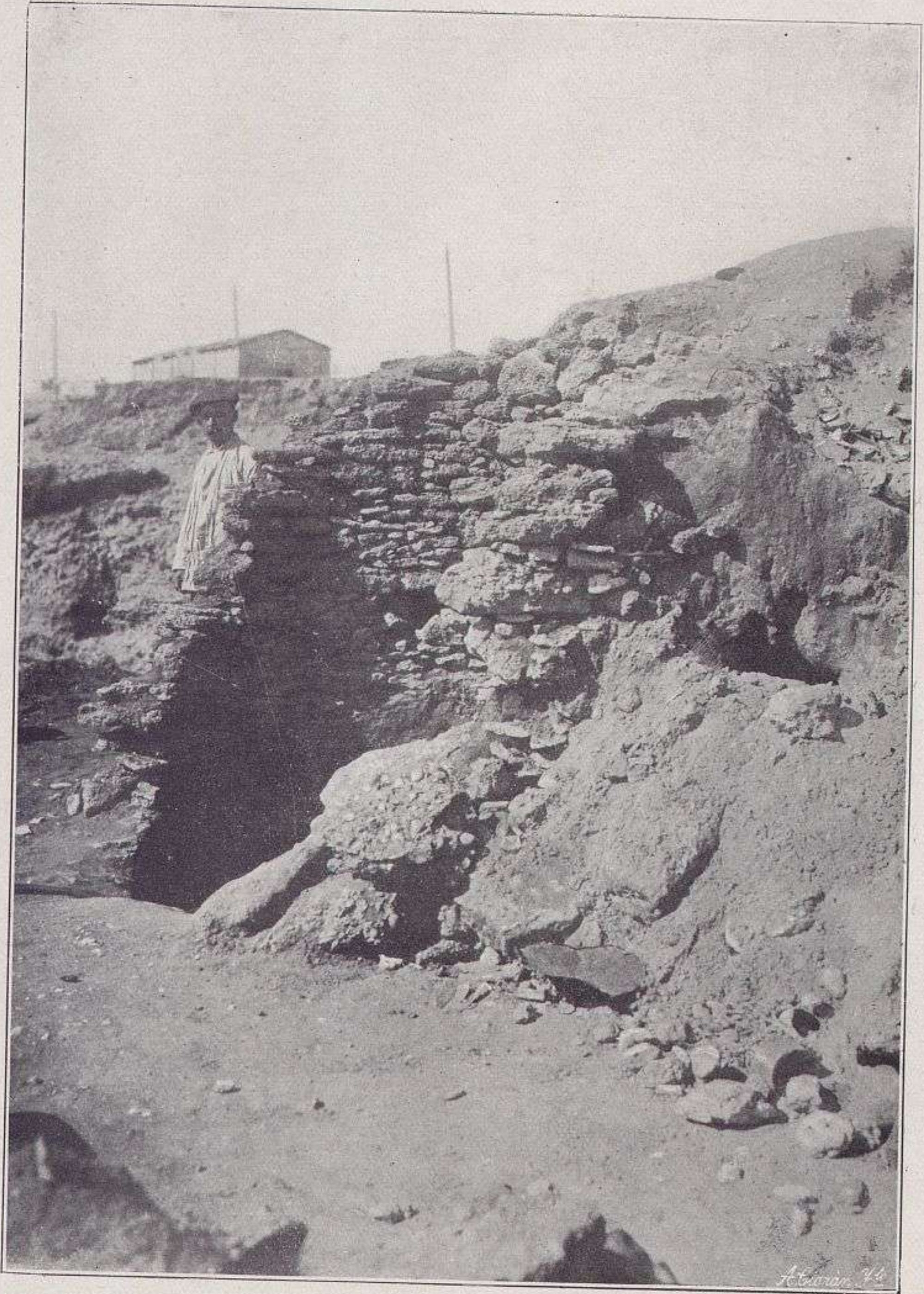
PARTE SUPERIOR DEL POZO
