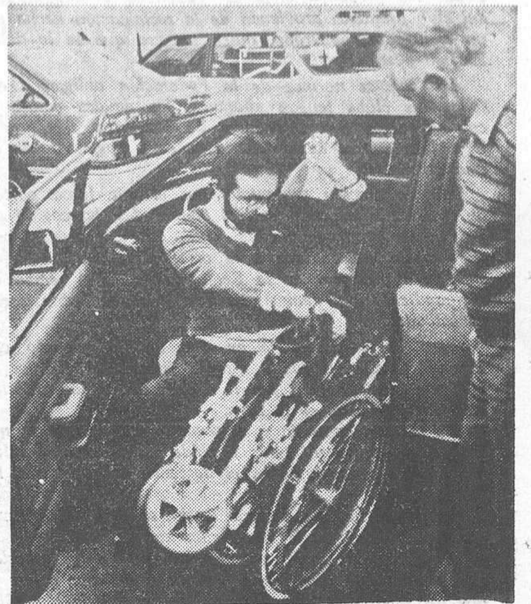
Nuevos aparatos contruidos en la República Federal de Alemania para ser instalados en automóviles facilitan a personas obligadas a usar sillas de ruedas, participar activamente de la locomoción motorizada. Los aparatos pueden ser instalados en casi cualquier coche de dos puertas. — (Foto DaO-Dziedzie).
