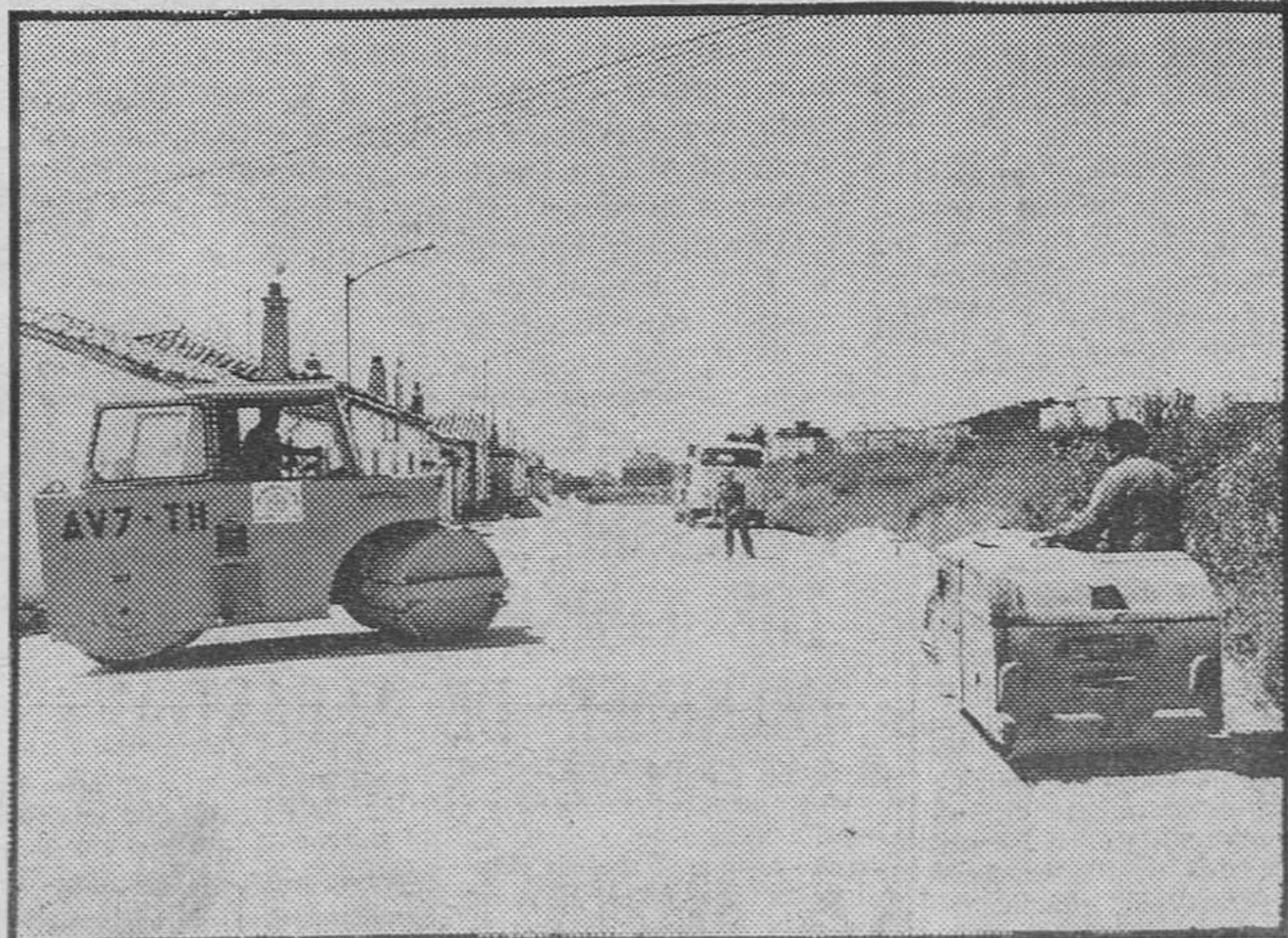
Las obras siguen. Próximamente todas las calles estarán asfaltadas. (Foto VILAFRANCA)
