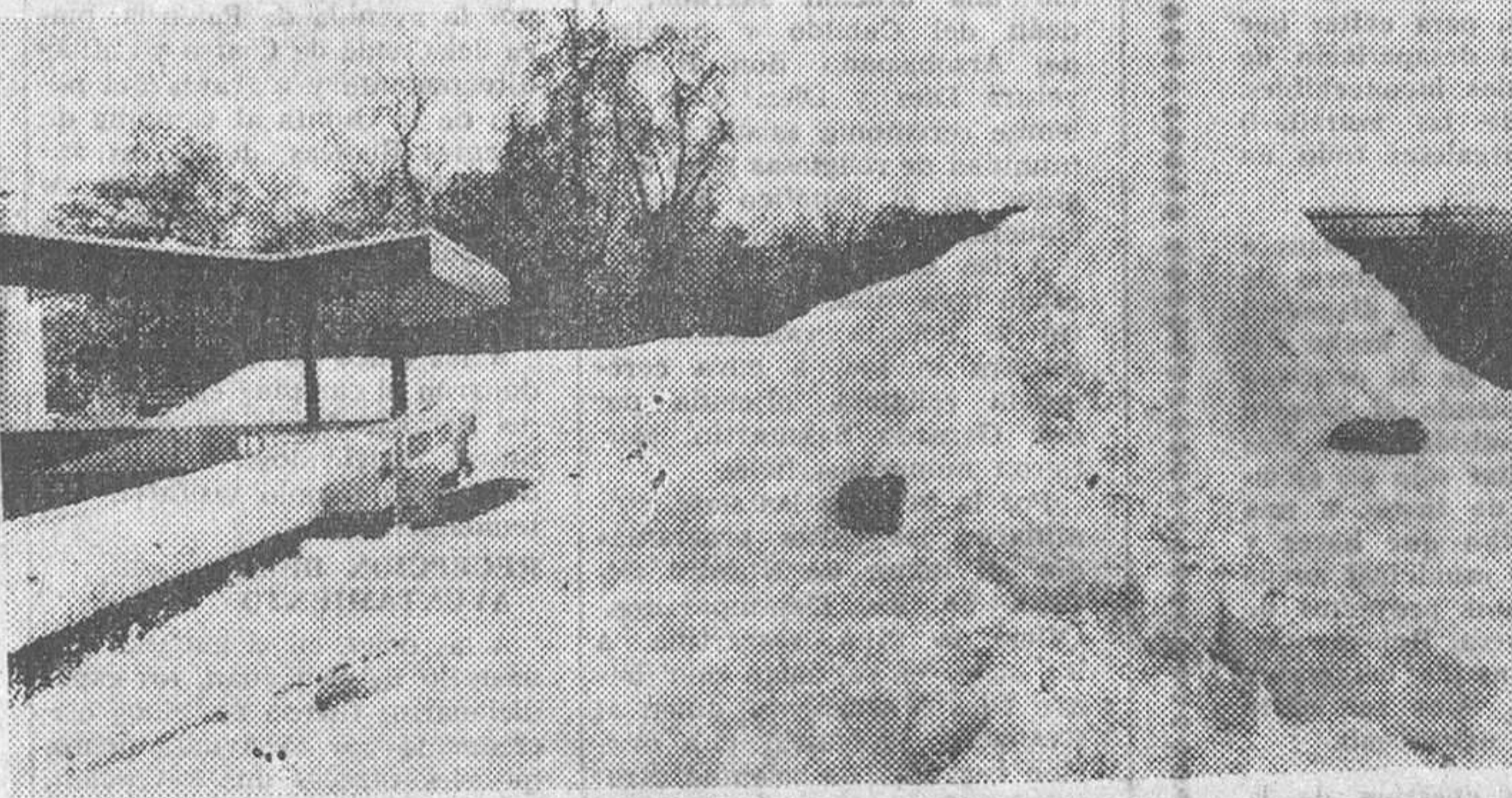
Nada de nieve. Se trata de espuma que, mezclada con semilla de césped y flores, serrín de turba y abono ha sido lanzada sobre el techo de un garaje subterráneo de Stuttgart, que también acoge una estación de servicio de mucho movimiento, para proteger de ruidos al vecindario. Con las lluvias, este "montículo" se convertirá en un bonito jardín. — (DaD).
