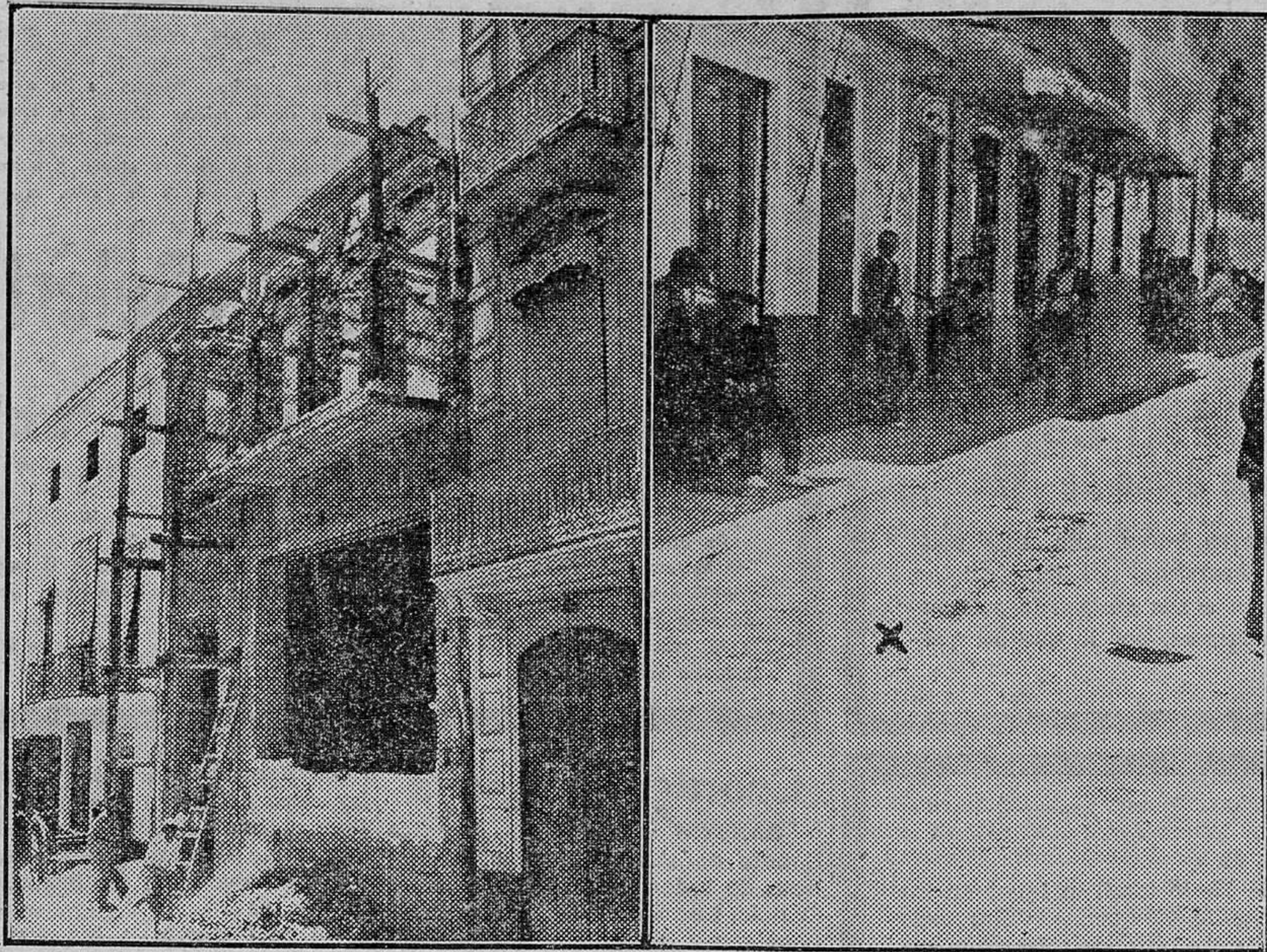
Buñol.—Obra en construcción donde se hicieron fuertes los revoltosos, haciendo fuego contra la Guardia civil y en donde izaron la bandera comunista.—Calle de Emilio Castelar, en donde se desarrollaron los sucesos. En el sitio marcado con una cruz cayó herido el teniente de la Guardia civil
