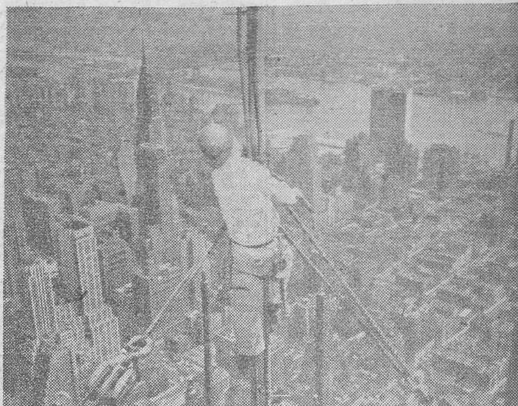
En la actualidad se está instalando en el edificio neoyorkino del Empire State una antena para radio y televisión de 68 metros de altura. Con ello, ese edificio, que es el más alto del mundo, tendrá una altura total de 449 metros.
