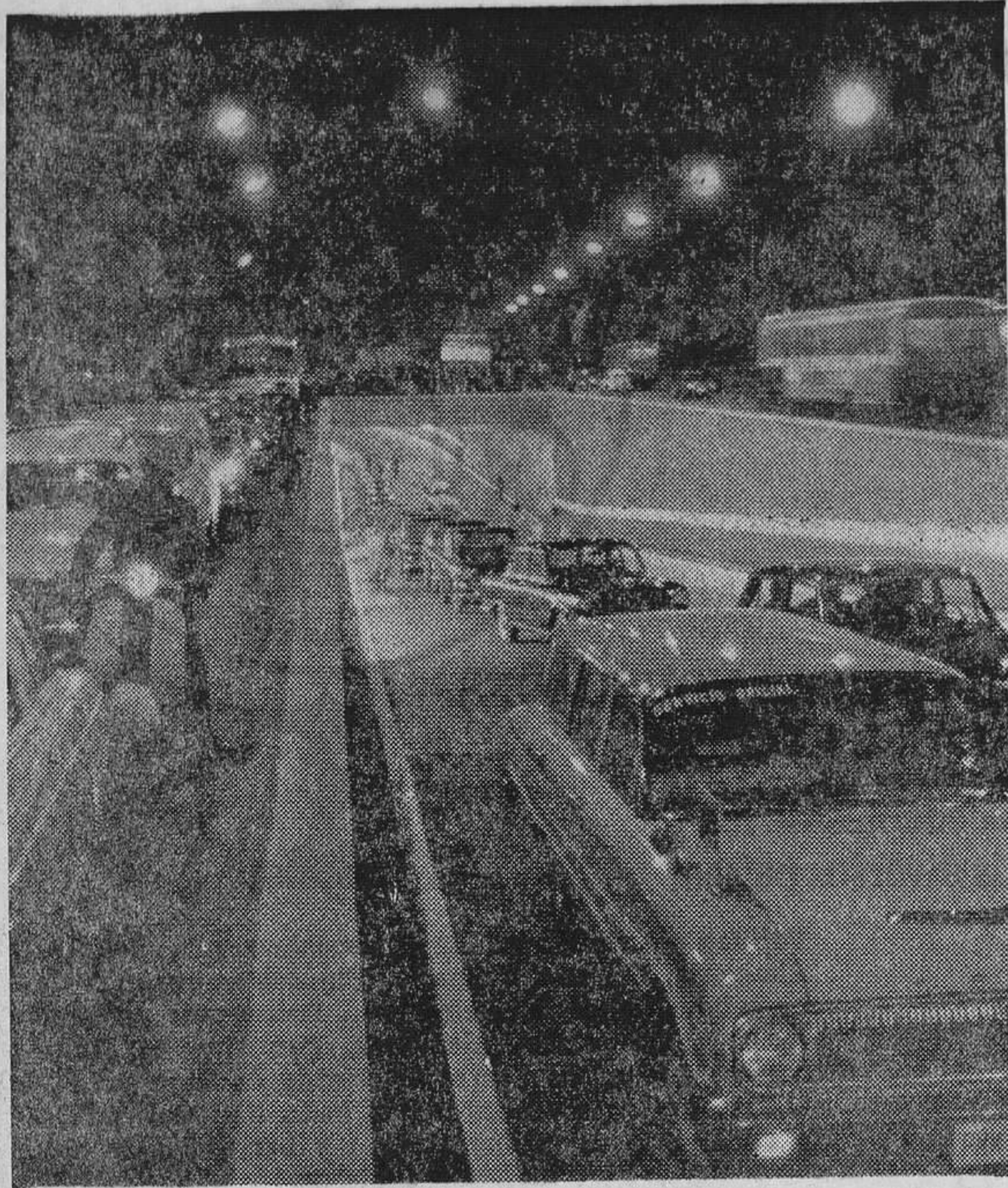
Coches oficiales inauguran con las autoridades municipales el nuevo paso subterráneo de vehículos de la madrileñísima calle de Alcalá, saliendo a dicha calle para unirse al resto del tráfico que, por la calzada normal, baja hacia la plaza de la Independencia
