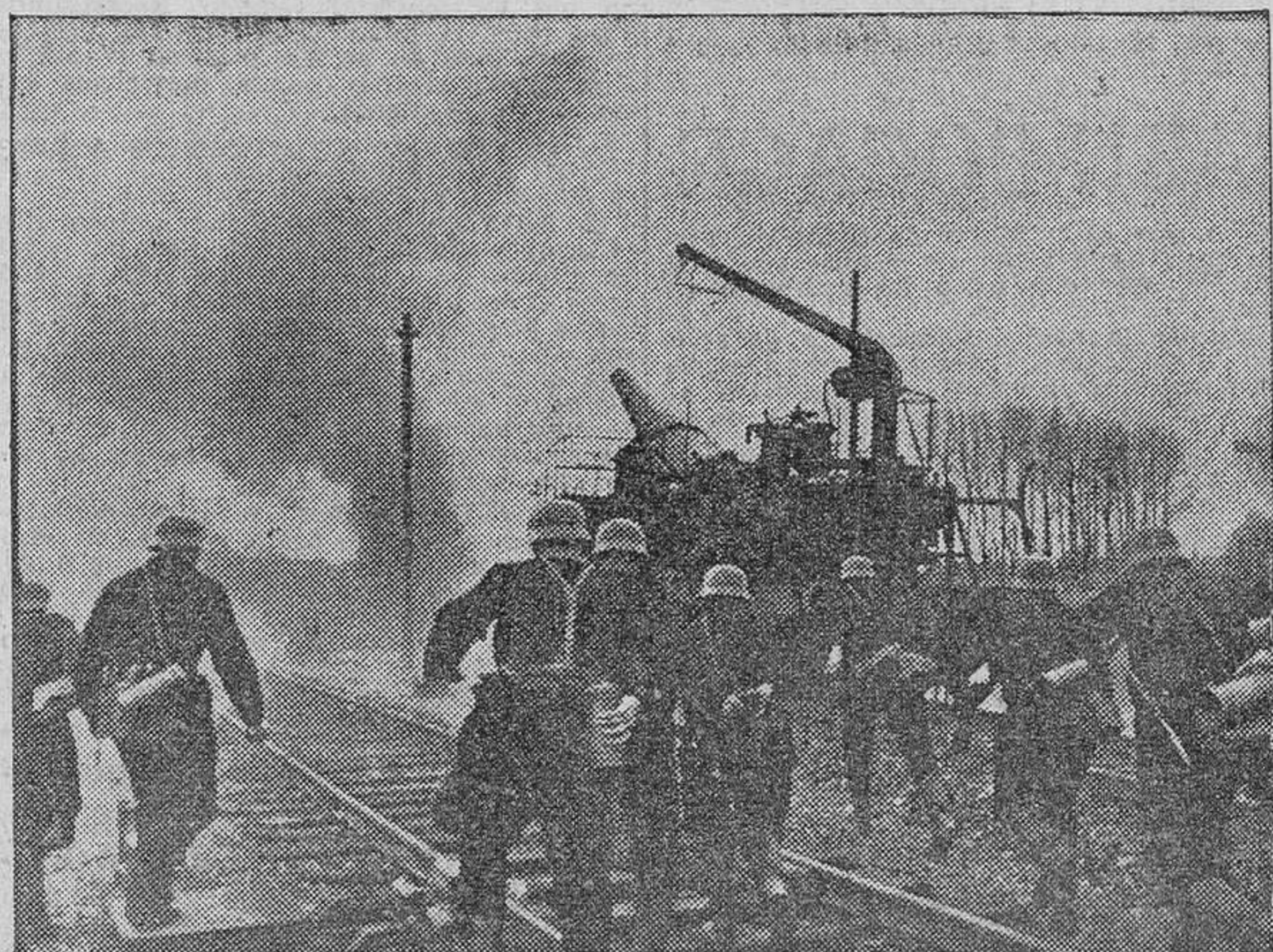
Baterías móviles alemanas, montadas en ferrocarriles, actúan activamente en el frente de invasión
